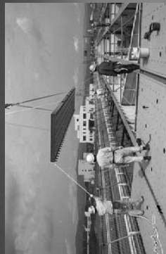
クレーンによる架設
