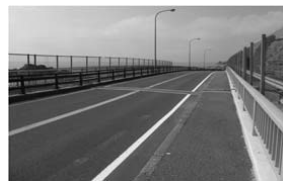
3径間連続PC有ヒンジラーメン箱桁橋 (35m+70m+35m)
