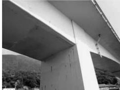
3径間連続PC有ヒンジラーメン箱桁橋 (35m+70m+35m)
