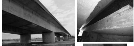
7径間連続PC有ヒンジラーメン箱桁橋 (73.2m+5@81.6m+73.2m)
