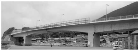
3径間連続PC有ヒンジラーメン箱桁橋 (35m+70m+35m)
