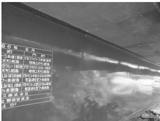
写真1 腹板の状況 ふっ素樹脂部 27年経過時 橋梁名: 常盤橋, 場所: 広島, 3種ケレン/エポキシ樹脂塗料/ふっ素樹脂塗料中/上
