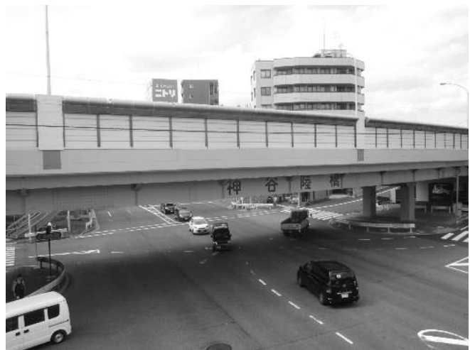
写真－5 リニューアルされた神谷陸橋
