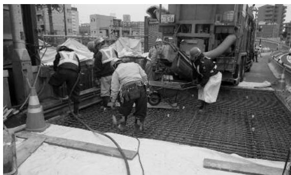
写真-2 床版連続化コンクリート打設
