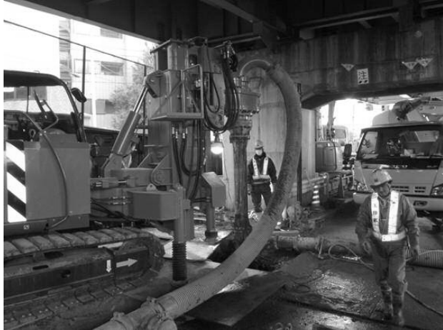
写真-1 増し杭施工
