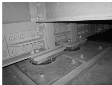
写真-3 支承取替え
