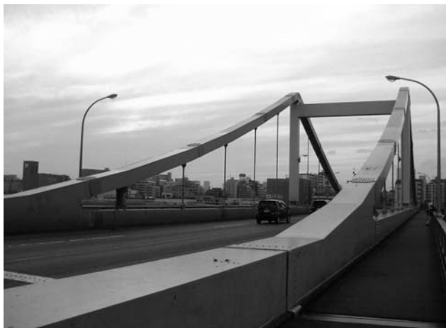
写真-4 突桁式鋼箱桁吊橋（1963年、橋長565.2m）
