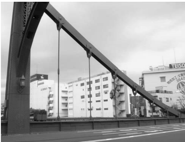
写真-2 主構部（路上）
