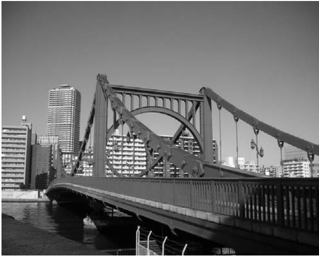
写真-1 自碇式連続鋼吊橋（1928年、橋長186.2m）
