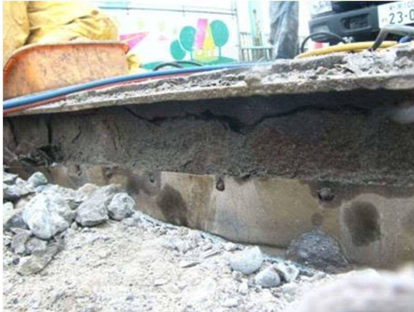
ウェブプレート破断
