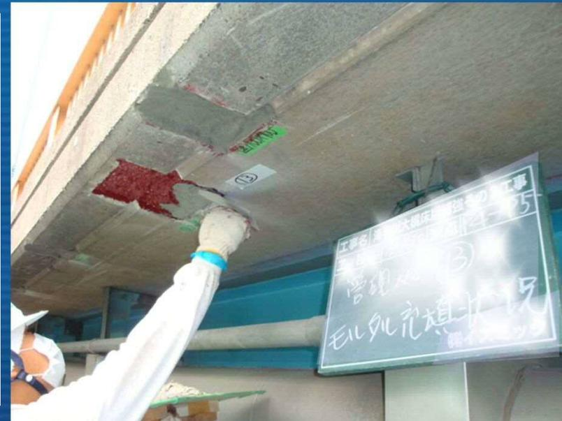
脆化箇所への復旧、鉄筋防錆、
