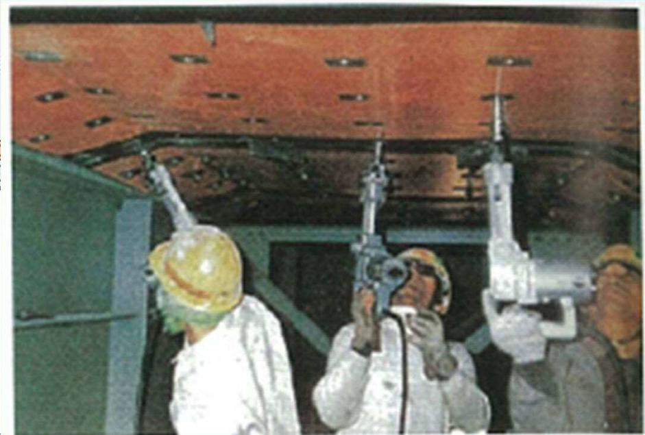
曲げ耐力不足を補う、樹脂とアンカーボルトを併用して床版と一体化
