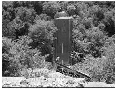
写真-2 崩落した祭時大橋
