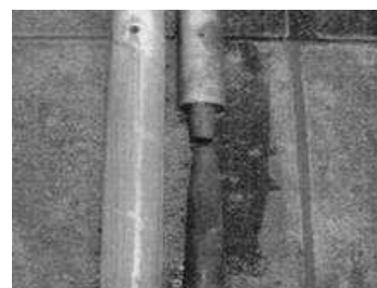
写真-7 保護管と鋼棒の状況
