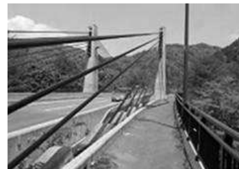
写真-8 斜材破断の状況
