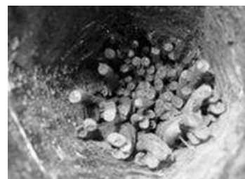
写真-9 斜材の破断部
