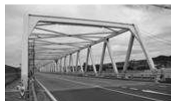
写真-12 本荘大橋
