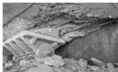
写真-5 主桁側の破壊が著しい支承部の被災
