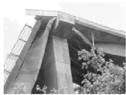
写真-15 桁の横倒れ
