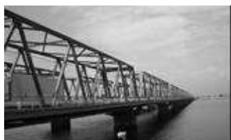
写真-10 木曾川大橋
