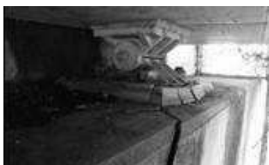
写真-4 下部工本体の破壊が著しい支承部の被災
