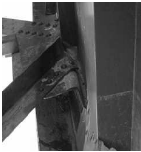
写真-13 ガセットの塑性化
