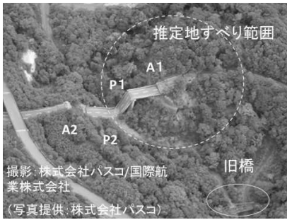
写真-1 祭時大橋架橋位置
