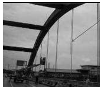
写真-6 吊り材破断の状況
