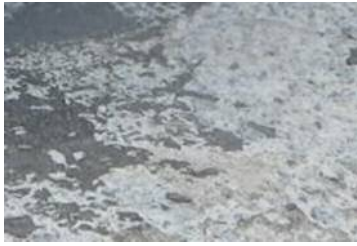
写真-4 舗装撤去後の床版上面の状況
