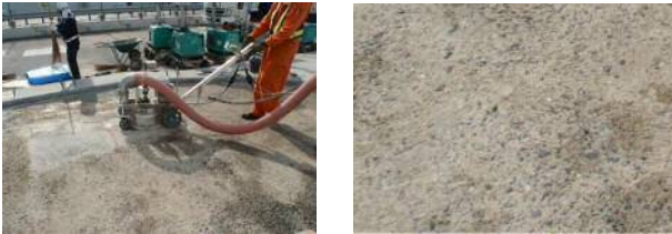
(a) スピンジェット施工状況 (b) 除去後の床版面
