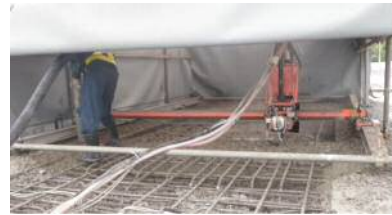
写真-3 WJによる劣化部コンクリートの撤去状況
