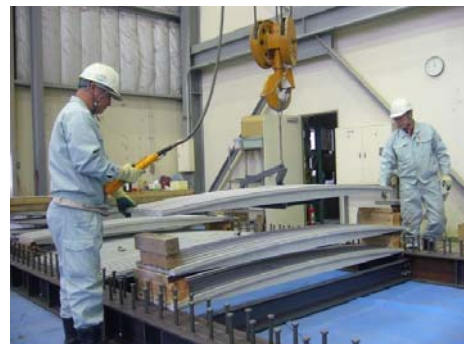
写真-1 RAFの敷設状況
