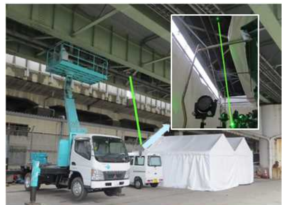
写真-2 実橋計測状況
