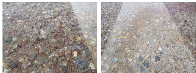
WJ 処理後 → 床版薄層研削機による切削後
