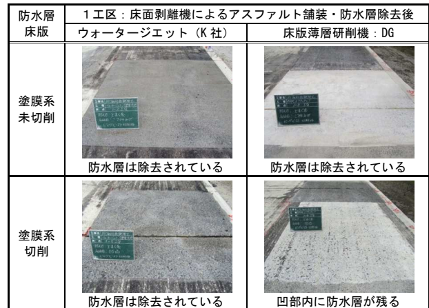
(a) WJおよび床版薄層研削機による二次処理
