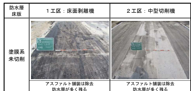
写真-3 一次処理後の床版面
