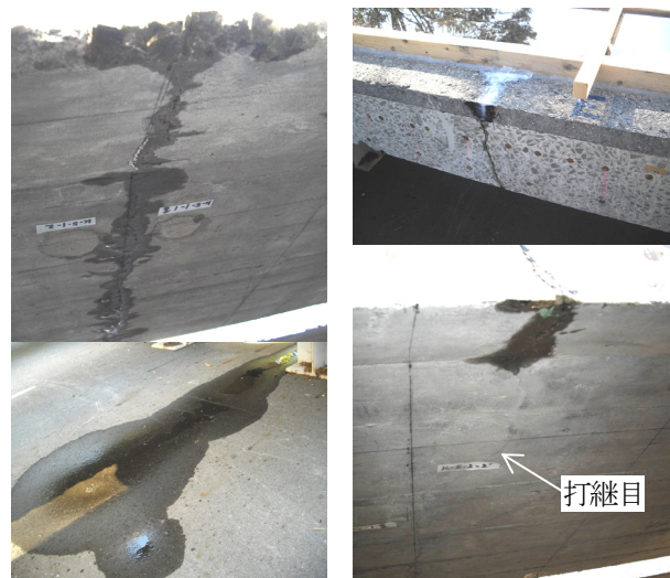
(a) As舗装なし (b) As舗装あり 写真-4 水張り開始直後の状況
