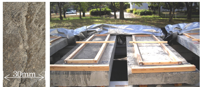
写真-2 床版下面の打継目 写真-3 水張り試験(左:As 舗装あり, 右:As 舗装なし(除去))
