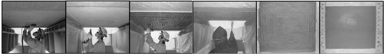
(1)表面研掃 (2)アンカー取付 (3)引張材取付取 (4)PCM吹き付け (5)吹き付け完了 (6)表面処理 プライマー塗布
