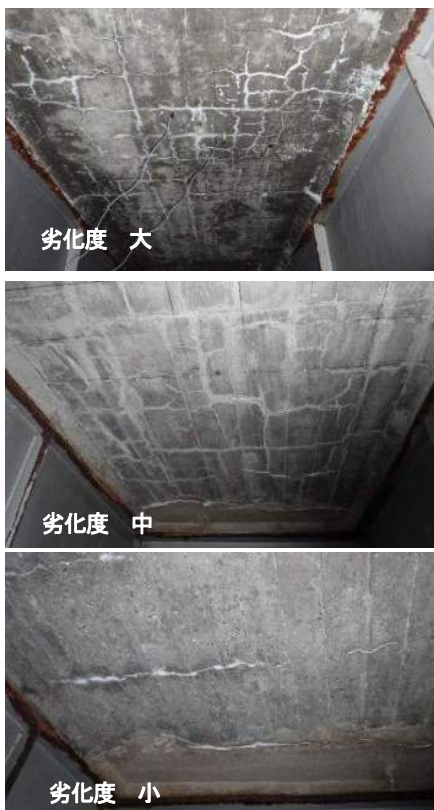
図 3.4 車両載荷試験に用いた床版パネル
