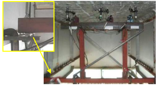
図 3.5 床版たわみ計測設備
