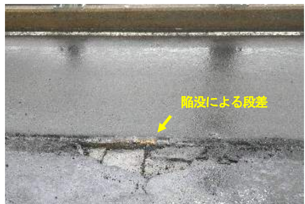
図 1.2 陥没の状況
