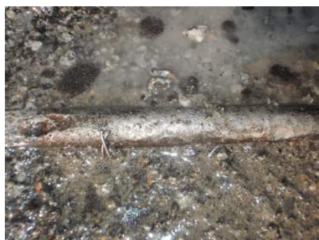
図 3.3 上面鉄筋の健全な状況
