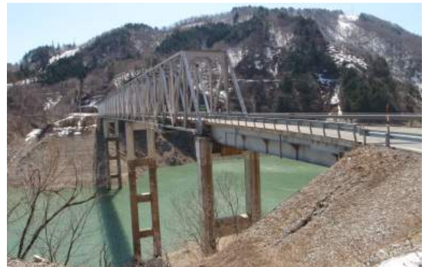
図 1.1 対象橋梁の側面状況
