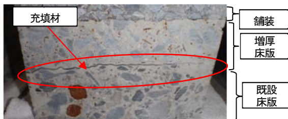
写真-5 充填材注入状況
