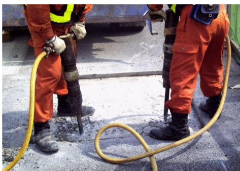
写真-1 プレーカ等によるハツリ処理
