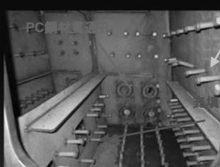
接合部内部組立て状況 (主桁下段)
