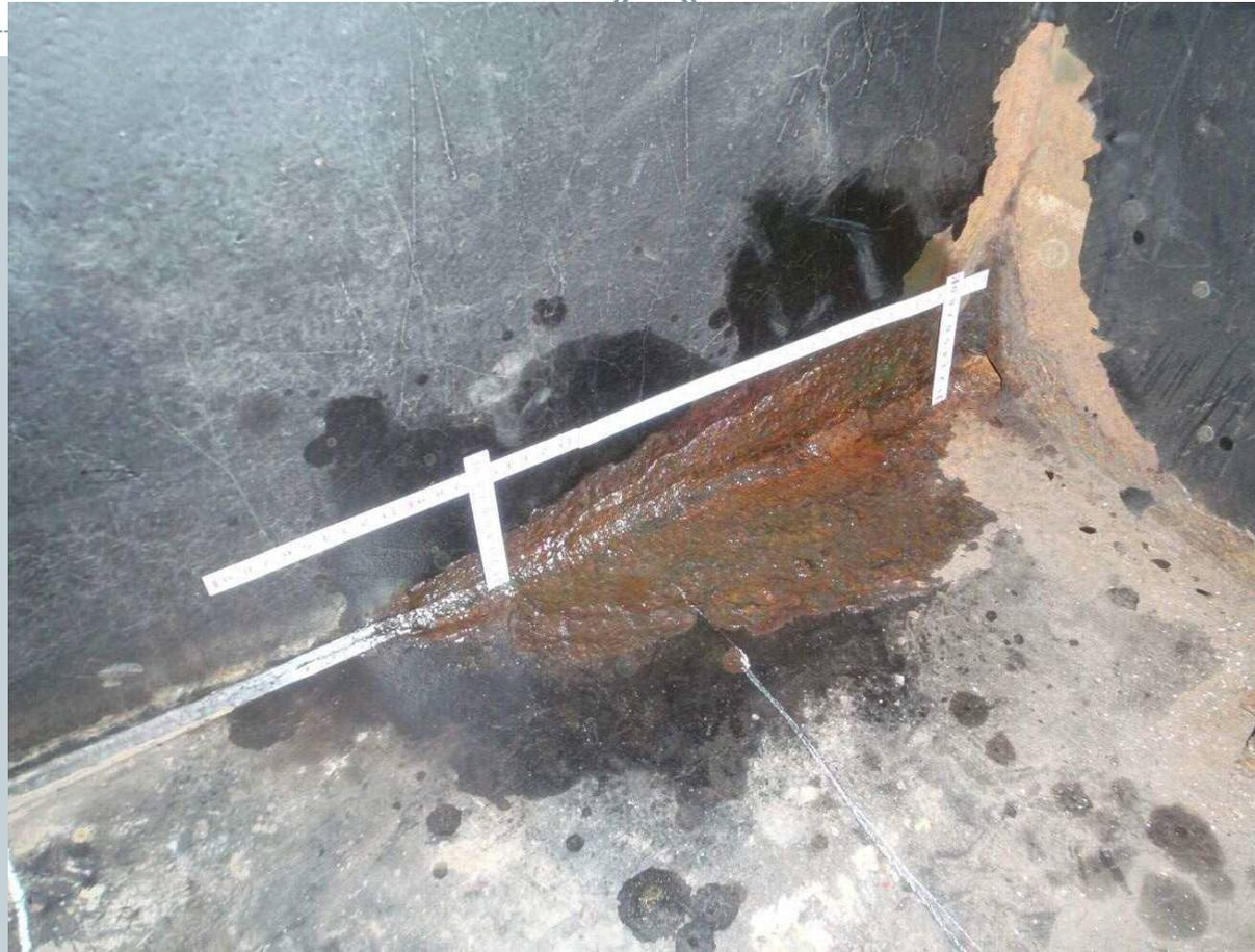
ウェブ( $t=9\text{mm}$ ), フランジ( $t=10\text{mm}$ )が2~3mm程度に腐食で減厚
