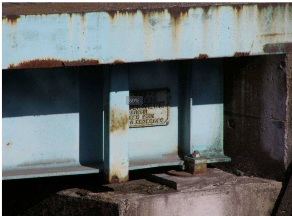
排水管流末不良の例
