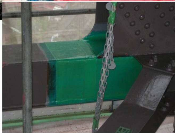
鋼トラス橋補修例
