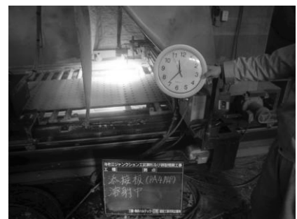
金属溶射施工
