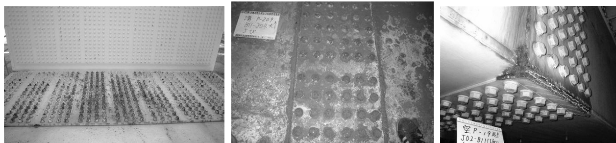
写真-1 ボルト継手部の劣化状況例
