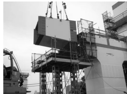
ブロック架設
