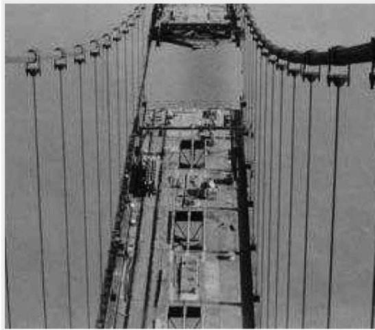
図-3 Pont de Tancarville (1959年) 合成床版の架設状況 1)
