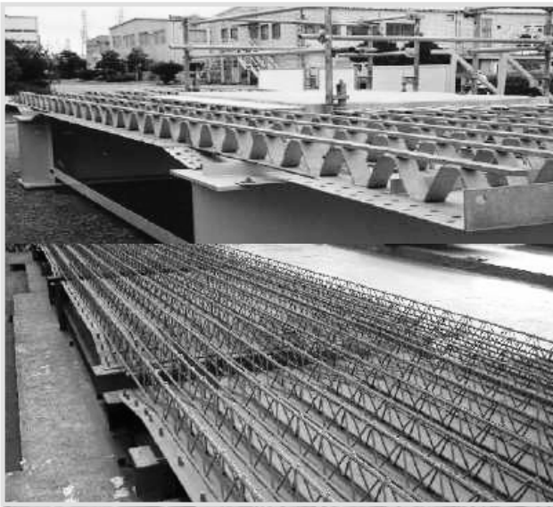
(c) トラスジベルタイプの例
