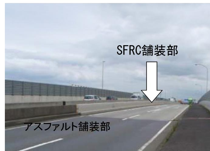
鋼床版上のSFRC舗装の施工事例
