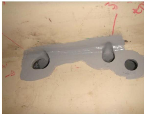
短いき裂の場合にはき裂先端の除去・応力集中緩和
