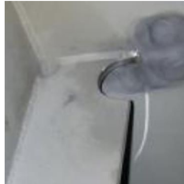
実橋に適用された補修例
