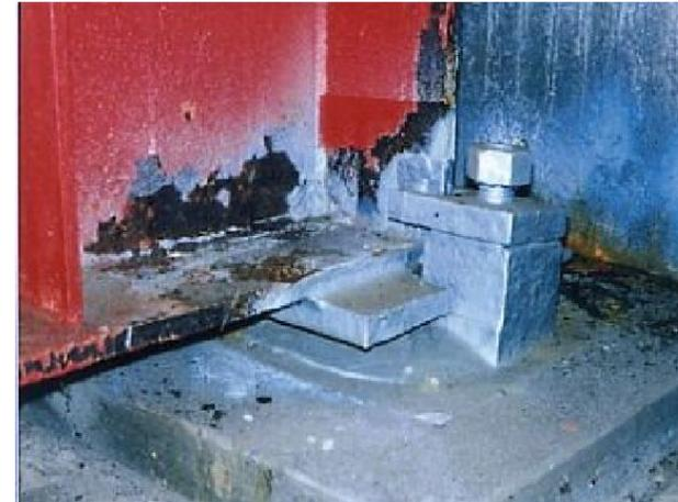
[ウェブ欠損(桁端側)]※
