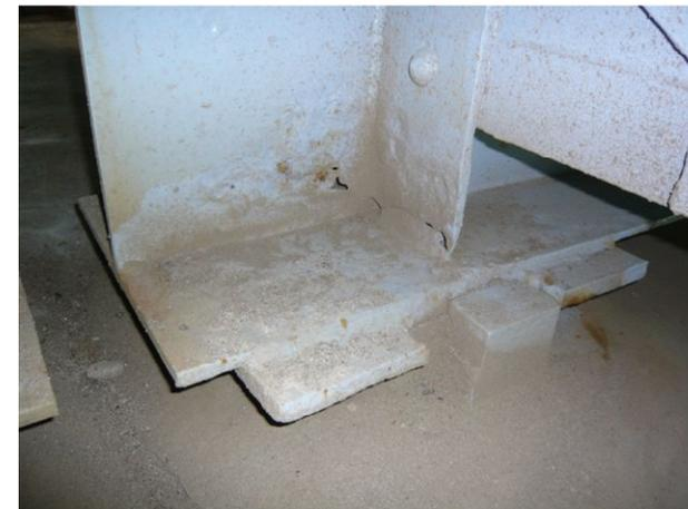
[補剛材とウェブ欠損(桁端側)]
