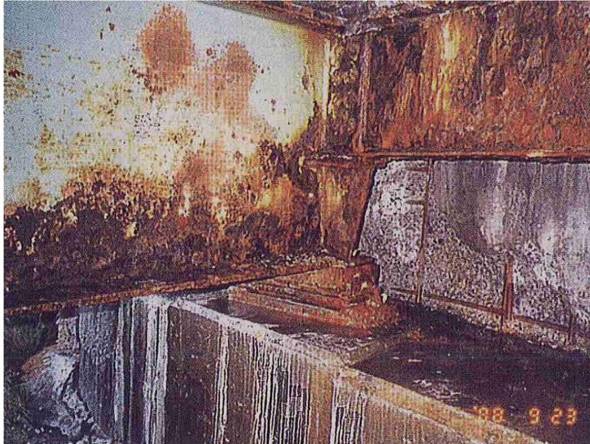
桁端部の局部腐食
