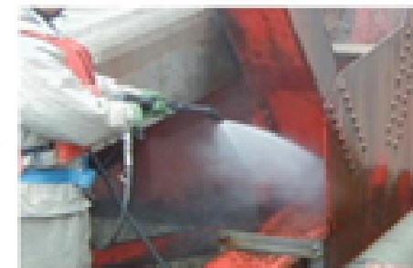
トラス橋洗浄中
