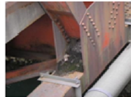
トラス橋洗浄前
