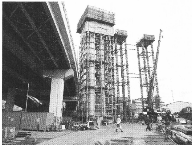
写真-1 架設完了の鋼管集成橋脚
