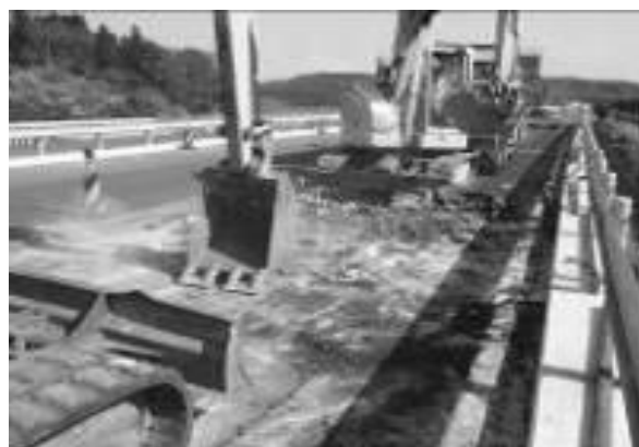
写真-1 バックホウによる 舗装除去作業
