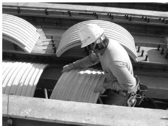
写真 - 4 曲面状埋設型枠の敷設状況
