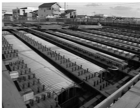
写真 - 3 曲面状埋設型枠の適用例
