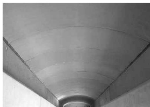
写真 - 6 曲面状埋設型枠を用いた床版の下面の様子
