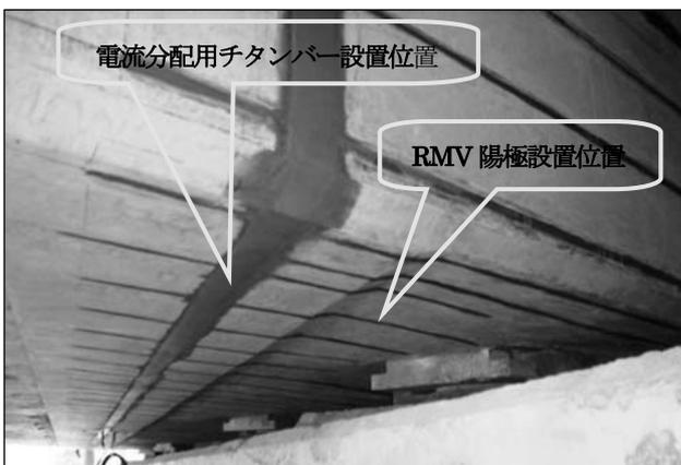
写真-11 狭隘部電気防食施工完了状況
