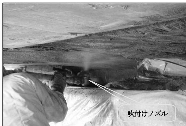
写真-7 吹付けによるはつり部の断面修復状況
