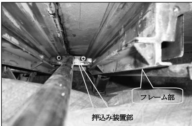
写真-10 フレーム押込み機によるV型陽極の押込み
