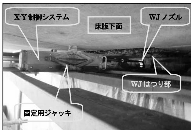
写真-2 X-Y 制御ウォータージェットはつり装置
