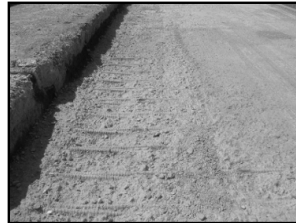
(1) 凍害による砂利化
