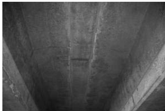
写真-1 床版下面の写真 (2011年11月撮影)
