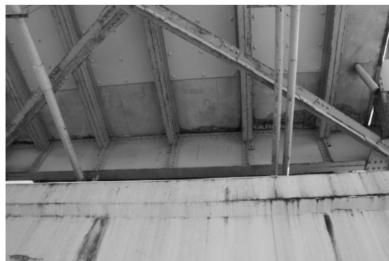
写真-3 鋼板接着と部分打替え (2011年11月撮影)
