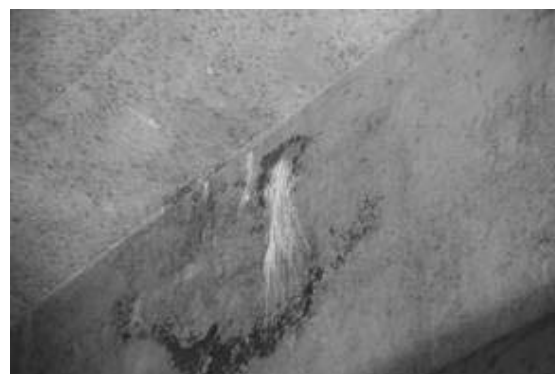
写真-2 主桁の写真 (2011年11月撮影)
