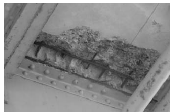
写真-4 拡大写真 (2011年11月撮影)
