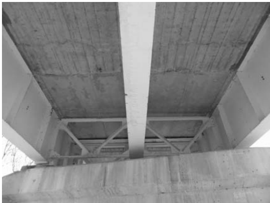
写真-6 補修後の状態 (2011年11月撮影)
