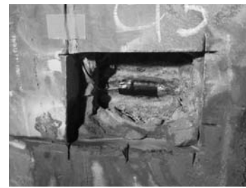
写真-2 主桁へのひずみ ゲージ添付状況
