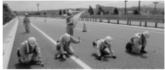
(a) 舗装面からの打音調査
