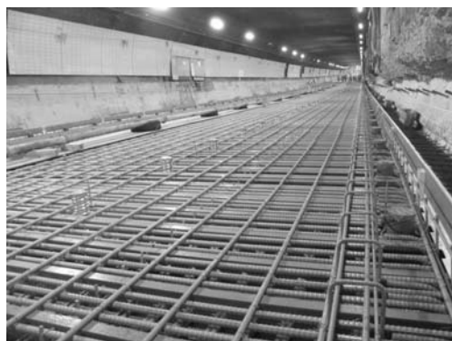
写真-7 床版鉄筋組立完了
