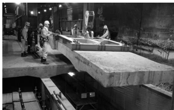
写真-3 床版撤去状況
