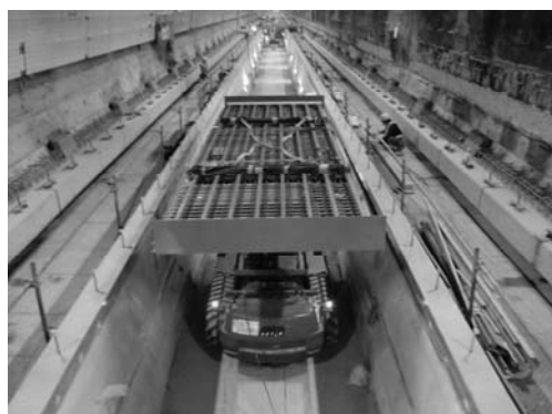
写真-5 FRP 型枠運搬状況
