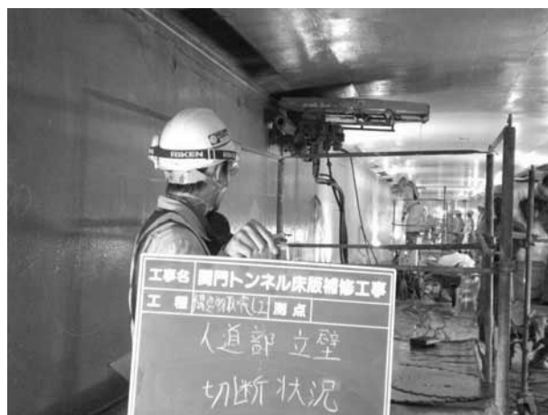
写真-1 ウォールソー切断状況
