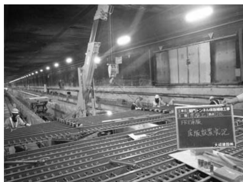
写真-6 FRP 型枠設置状況
