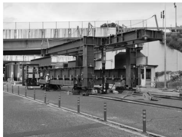
写真-2 専用の床版撤去台車
