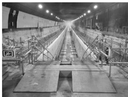
写真-4 床版撤去完了
