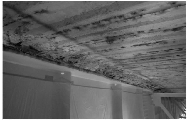
写真一 I 形鋼格子合成床版下面の劣化状況
