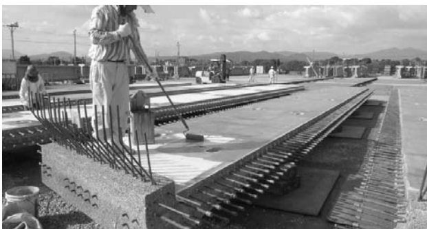
写真-4 PC 工場での床版防水プライマーの塗布
