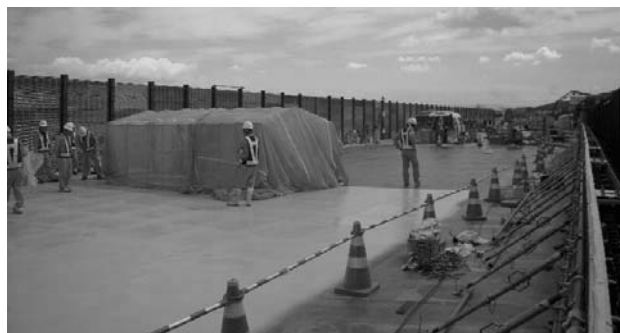
写真-5 壁高欄工と床版防水工との並行作業
