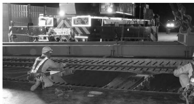
写真-3 架設中の継手内横方向鉄筋の挿入状況
