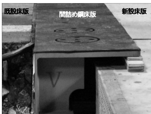
写真-4 間詰め鋼床版設置状況
