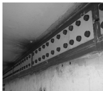
b) 主桁ウェブ仮添接
