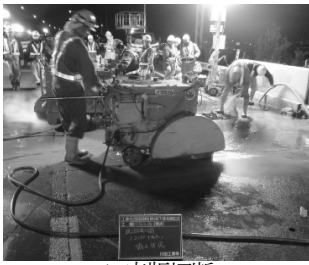
a) 床版切断
