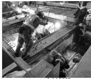
c) T字材架設
