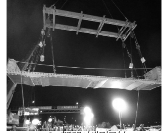
d) 新設床版据付
