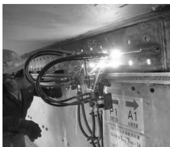
a) 主桁ウェブ切断
