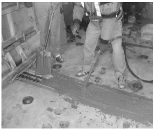
e) ジェットコンクリート打設
