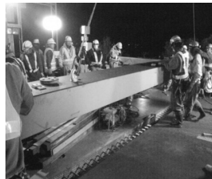
f) 間詰め鋼床版据付
