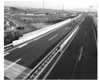
h) 本舗装完了
