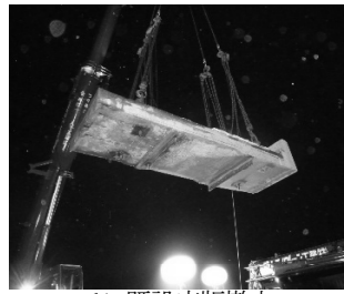
b) 既設床版撤去
