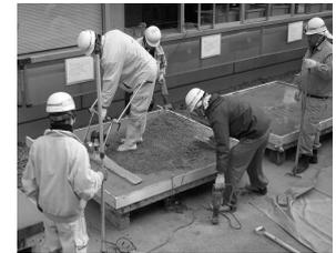
写真-5 SFRC 打ち込み
