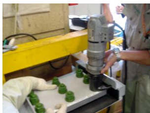
写真-3 ボルト締め付け状況
