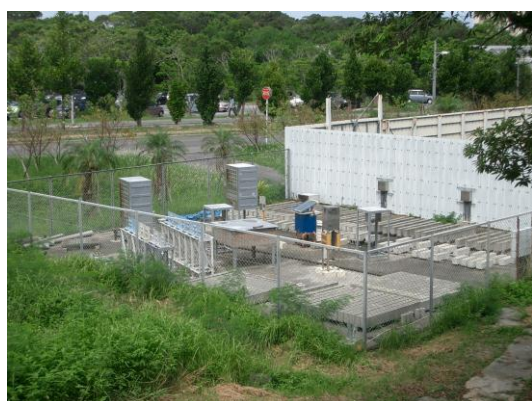
写真-6 琉球大学暴露試験場全景
