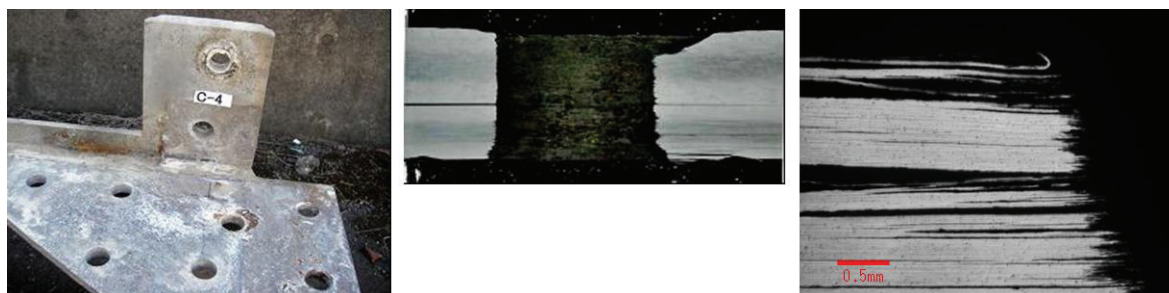
(1) ブラケット取付部 外観
