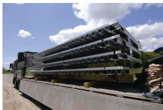
図-9 玉川橋アルミ床版搬入
