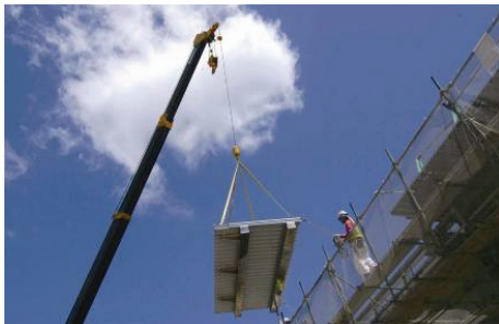
図-10 玉川橋アルミ床版吊り込み
