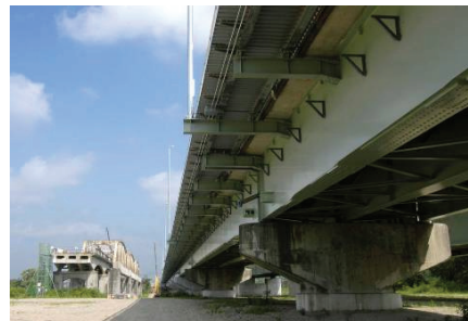
図-8 玉川橋拡幅後外観
