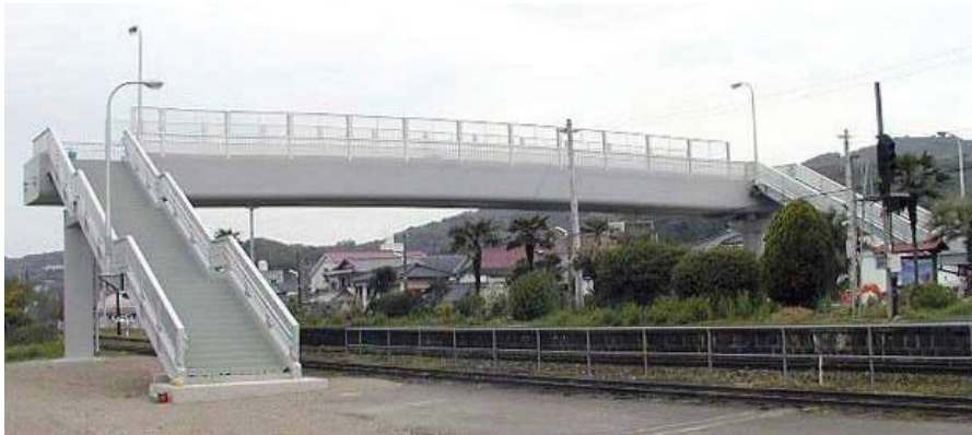
図-2 川棚駅自由通路外観
