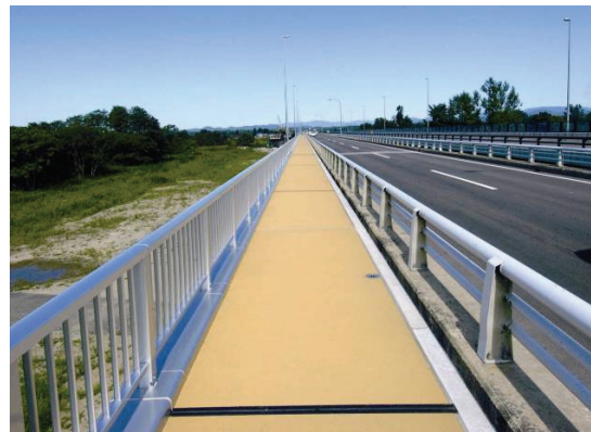
図-11 玉川橋拡幅後内観
