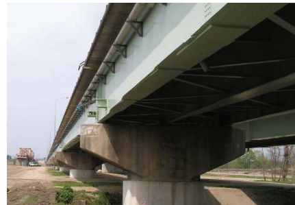
図-7 玉川橋拡幅前外観
