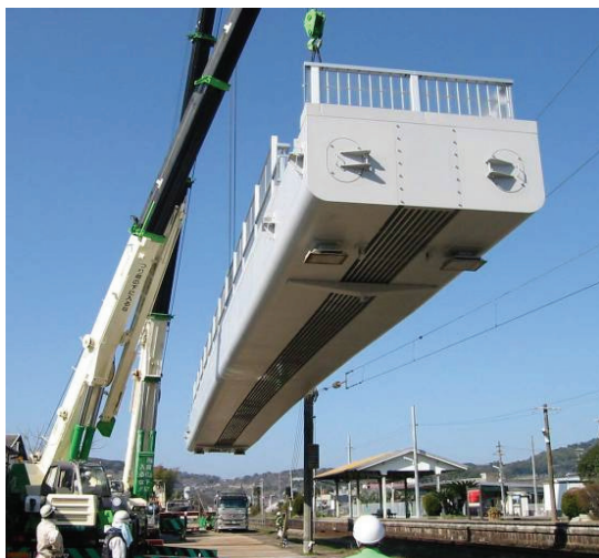
図-4 川棚駅自由通路本橋部吊り込み
