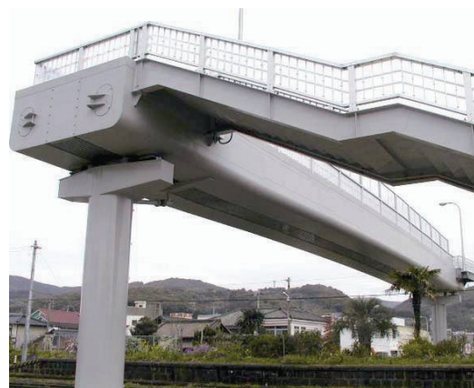
図-5 川棚駅自由通路支柱・階段部外観
