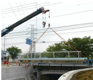
図-1 3 中央橋吊り込み
