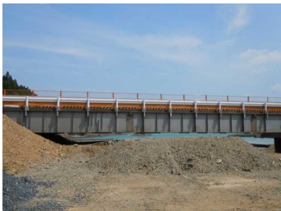
写真4 3 土砂流失部の仮橋設置状況
