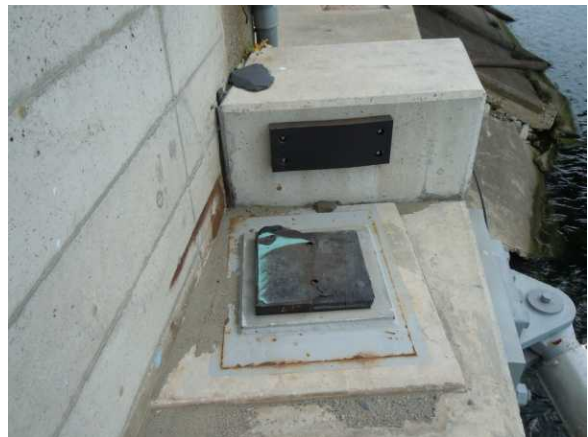
写真52 支承部の破損状況
