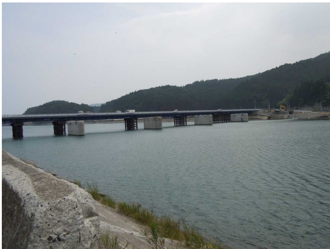
写真50 気仙大橋の仮橋設置状況
