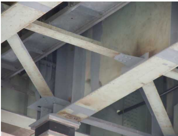
写真14 2次部材の補修
