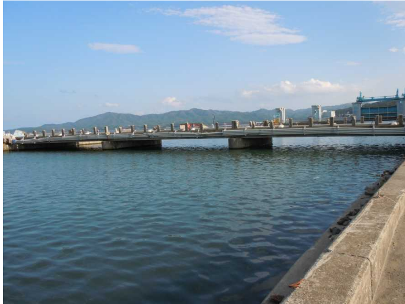
写真34 流失を免れた橋梁
