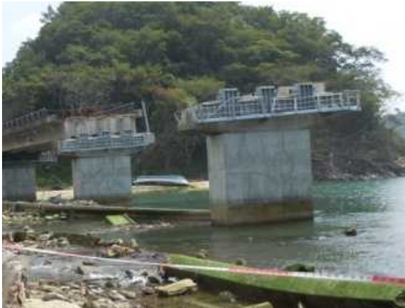
写真38 落橋防止突起の存置状況
