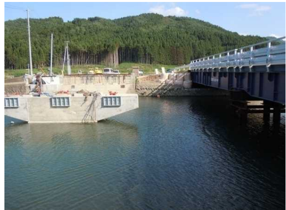
写真23 橋桁流失後の状況と仮橋
