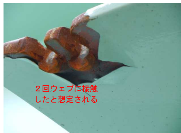
写真16 ランプ橋の部材損傷状況
