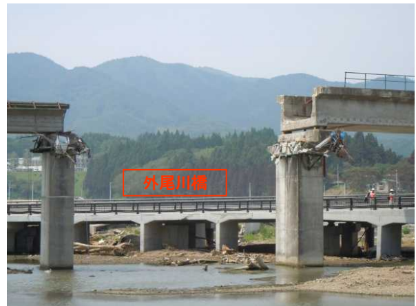
写真４７ 流失したＪＲ気仙沼線 小泉橋りょうと外尾川橋
