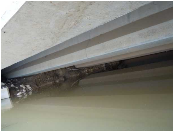
写真56 沼田跨線橋 流失桁の状況
