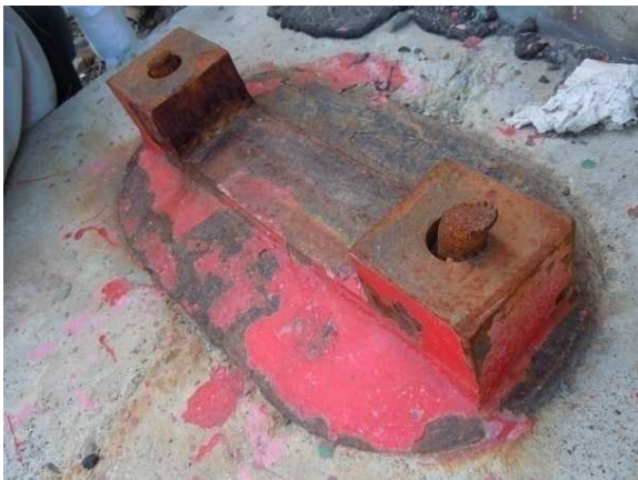
写真24 線支承の破損状況
