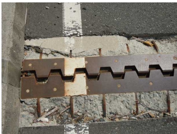
写真39 支承部・伸縮装置の状況
