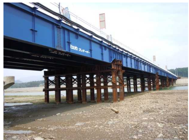
写真46 小泉大橋 仮橋設置状況
