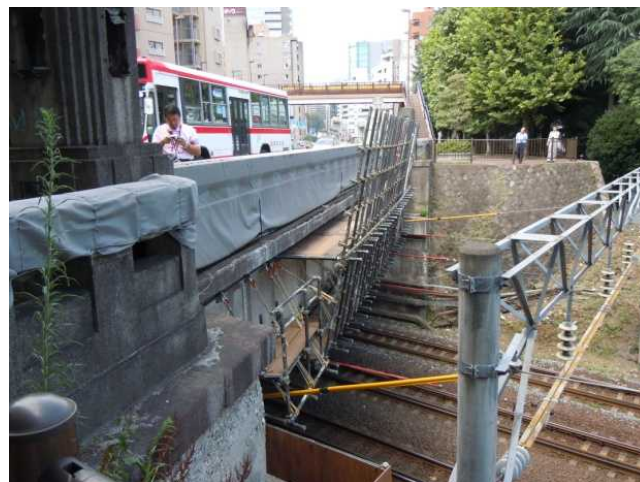
写真7 吊足場が設置されていた跨線橋
