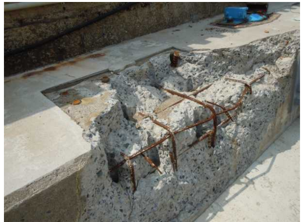
写真45 小泉大橋 橋台部の損傷状況
