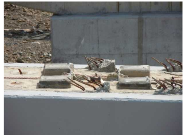
写真38 落橋防止突起の存置状況
