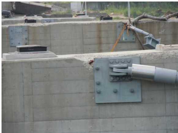
写真52 支承部の破損状況
