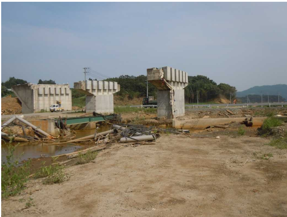
写真55 沼田跨線橋の現況
