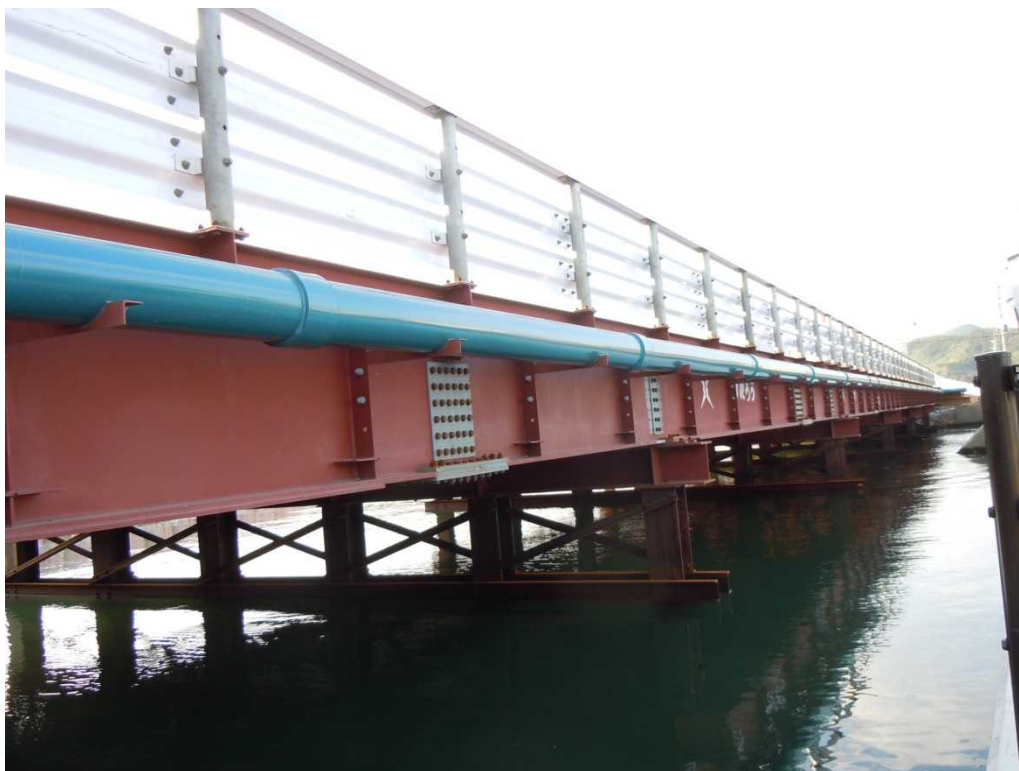
写真33 仮橋設置状況
