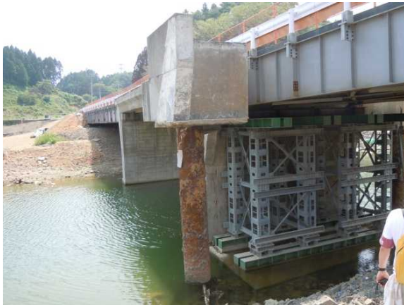
写真4 1 流失した側道橋の橋台鋼管杭露出状況
