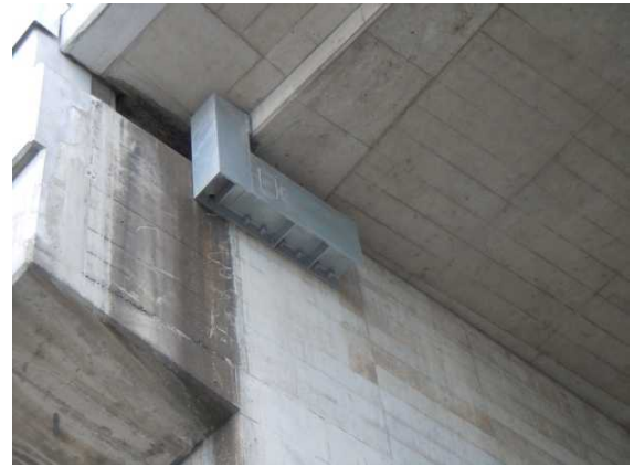
写真5 鋼製ストッパー設置状況
