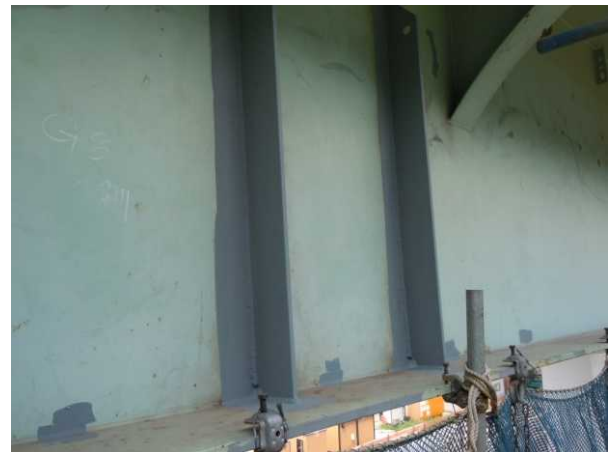
写真15 ベント支持用に設置された補剛材
