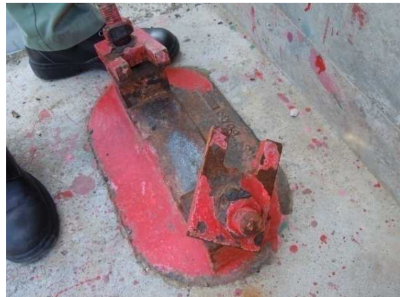
写真24 線支承の破損状況
