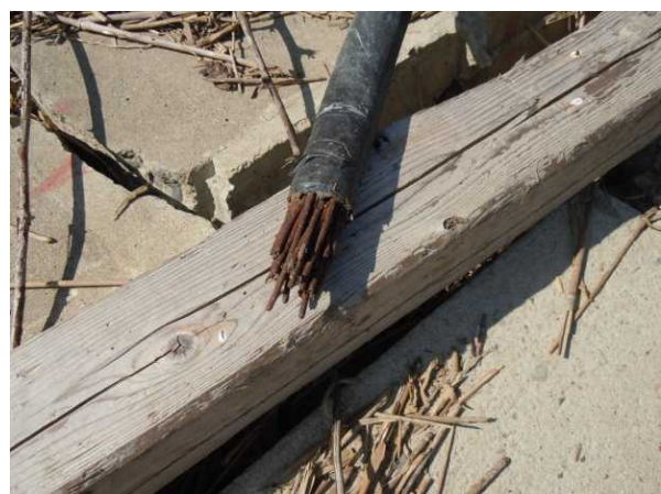
写真21 落橋防止ケーブル損傷状況
