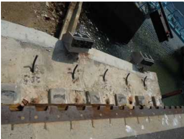
写真38 落橋防止突起の存置状況
