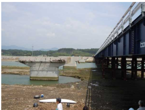
写真46 小泉大橋 仮橋設置状況
