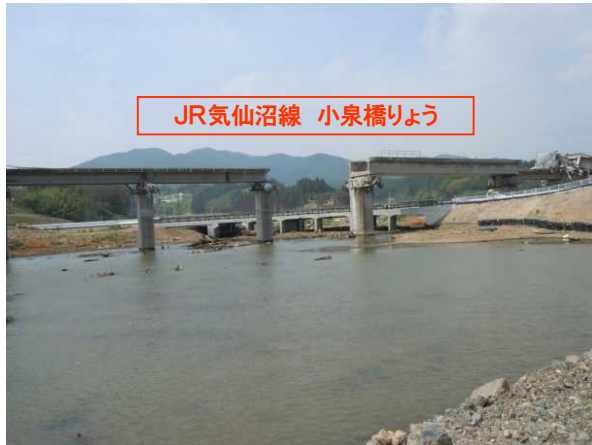
写真４７ 流失したＪＲ気仙沼線 小泉橋りょうと外尾川橋
