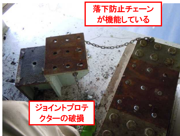
写真10 P56上のジョイントプロテクター
