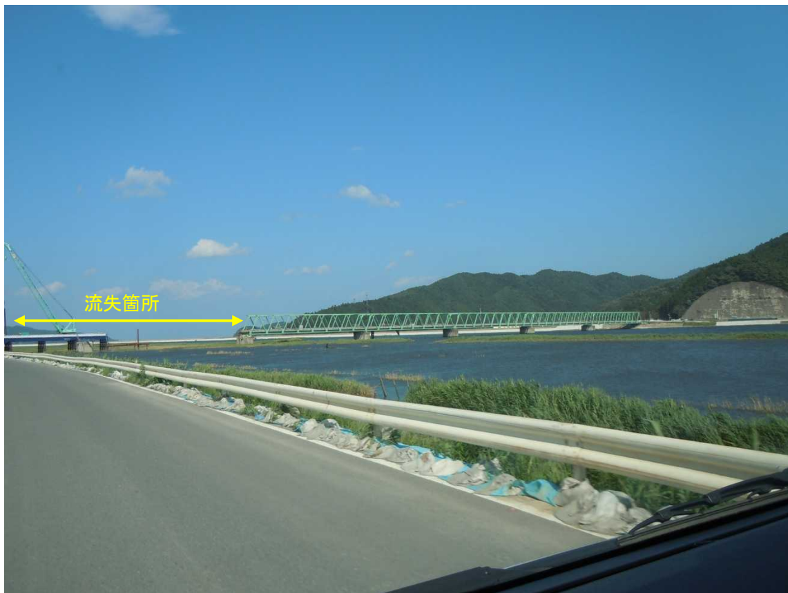
写真18 新北上大橋 全景
