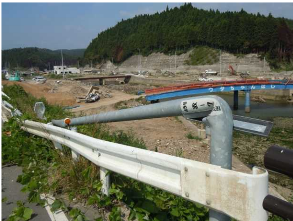
写真 4 1 照明柱の損傷と流失を免れた橋梁
