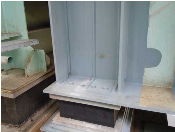
写真12 P56 復旧されたゴム支承
