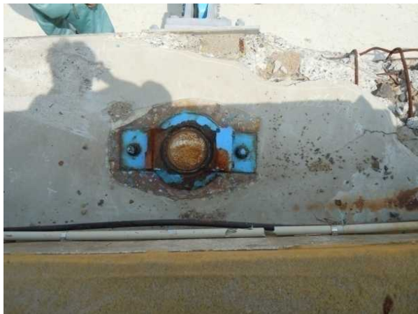
写真45 小泉大橋 橋台部の損傷状況
