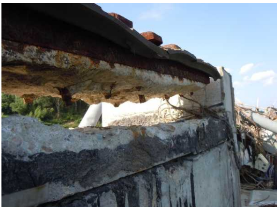
写真25 伸縮装置アンカー下端からの浮きあがり
