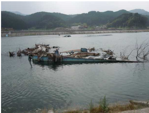
写真51 流失した桁の現況
