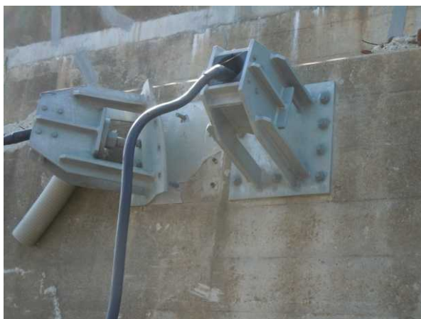
写真21 落橋防止ケーブル損傷状況
