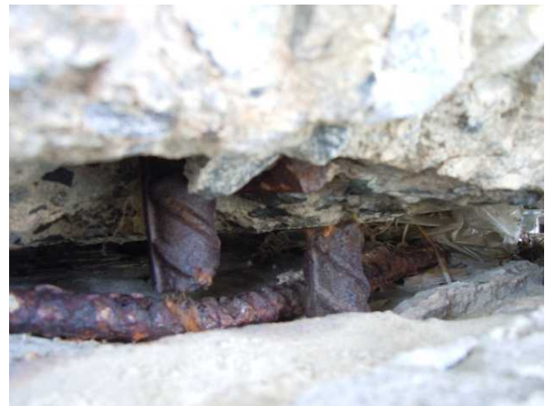
写真 4 0 橋脚の損傷状況
