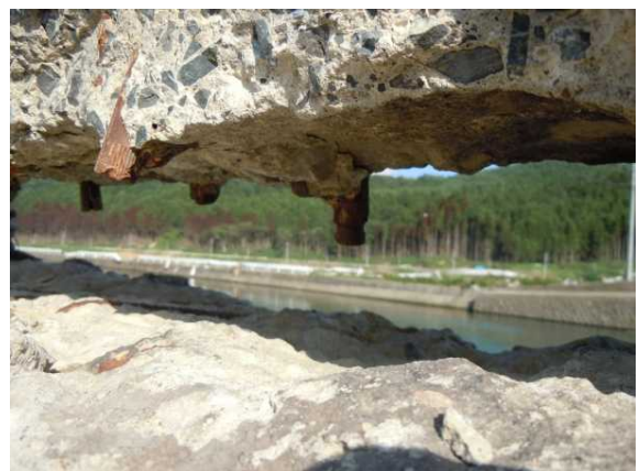
写真25 伸縮装置アンカー下端からの浮きあがり
