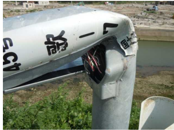
写真 4 1 照明柱の損傷と流失を免れた橋梁
