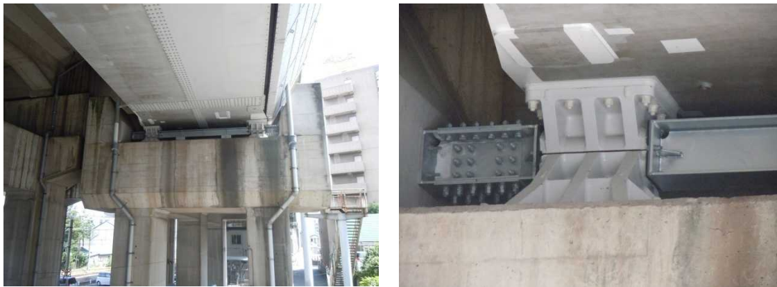
写真3 補修完了状況
