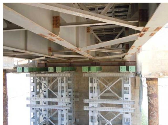
写真4 3 土砂流失部の仮橋設置状況
