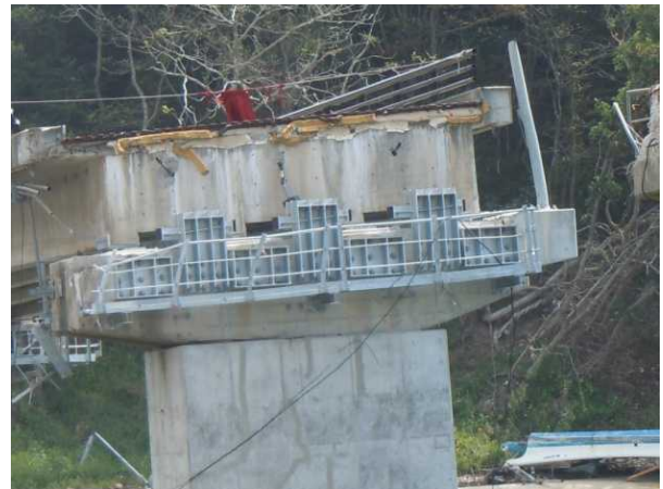
写真38 落橋防止突起の存置状況
