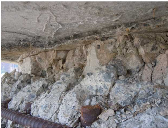
写真 4 0 橋脚の損傷状況
