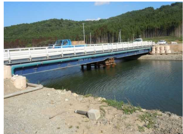
写真28 鋼製仮橋設置状況
