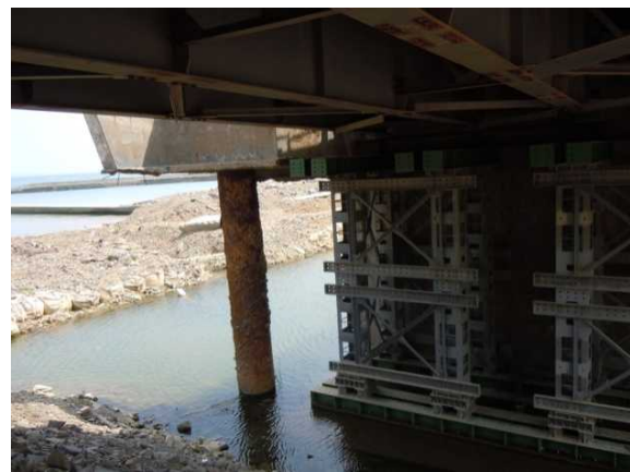
写真4 1 流失した側道橋の橋台鋼管杭露出状況
