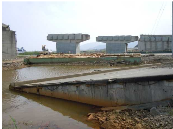
写真56 沼田跨線橋 流失桁の状況
