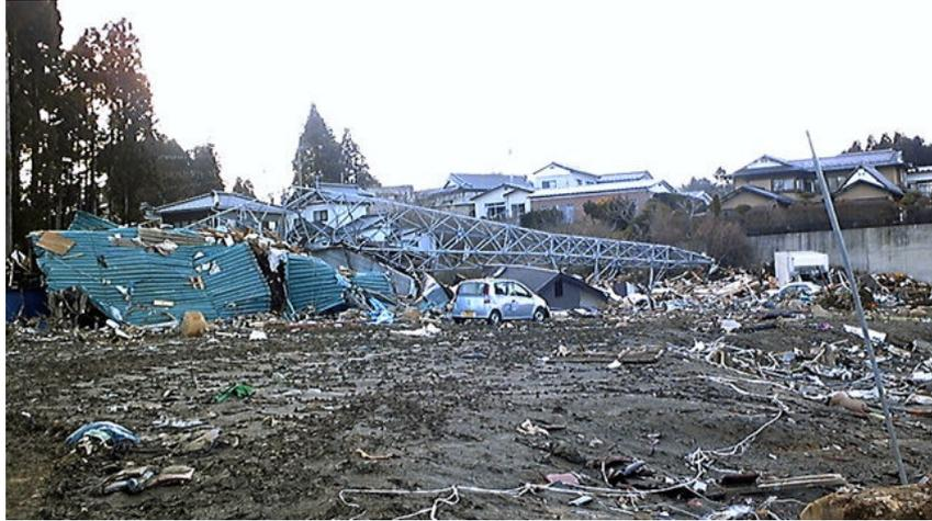
写真 2.4.15 松鹿線 3 号鉄塔の状況<sup>6)</sup> (宮城県気仙沼市) (写真提供:「送電鉄塔見聞録」)
