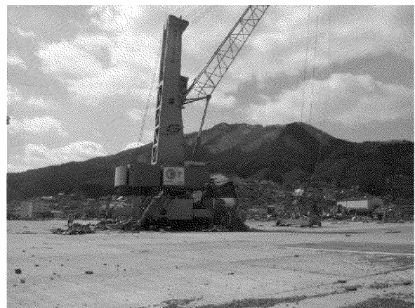
写真 2.3.20 ハーバークレーンの状況
