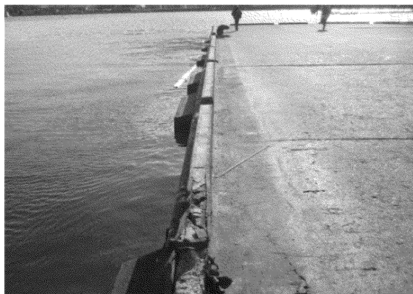
写真2.3.21 栈橋法線の状況(異常なし)
