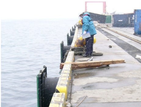
写真 2. 3. 36 高砂埠頭 2 号岸壁法線
