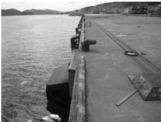
写真 2.3.17 栈橋法線の状況(異常なし)
