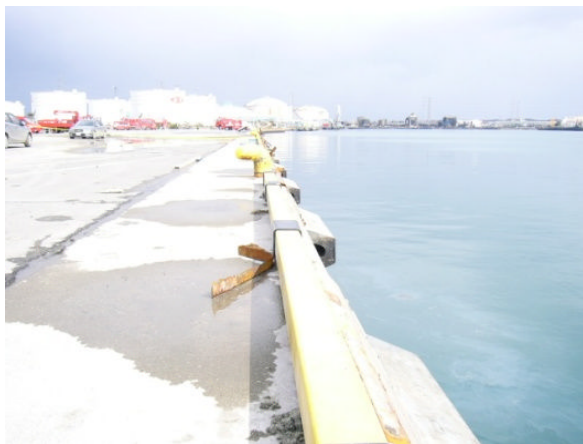
写真 2. 3. 30 高松埠頭 鋼矢板式耐震強化岸壁
