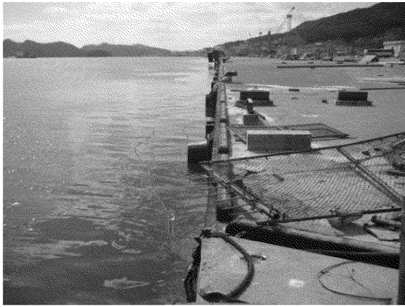
写真 2.3.13 栈橋法線の状況(異常なし)
