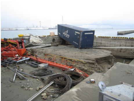
写真 2. 3. 38 高砂埠頭 2 号岸壁隅角部
