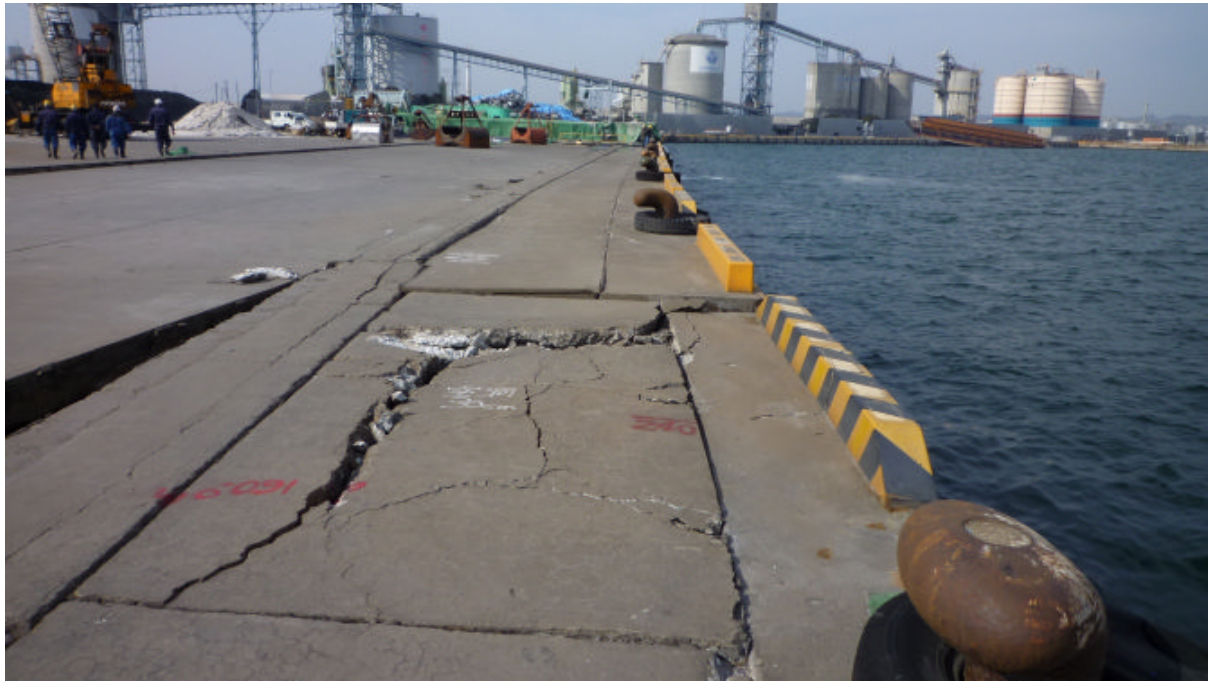
写真 2.3.29 相馬港 4号埠頭 鋼矢板岸壁とケーソン式岸壁の境界部分
