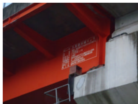
写真 2.2.8 橋軸直角方向応急ずれ止め対策
