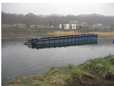
写真 2.2.31 第三十四閉伊川橋りょう被害状況
