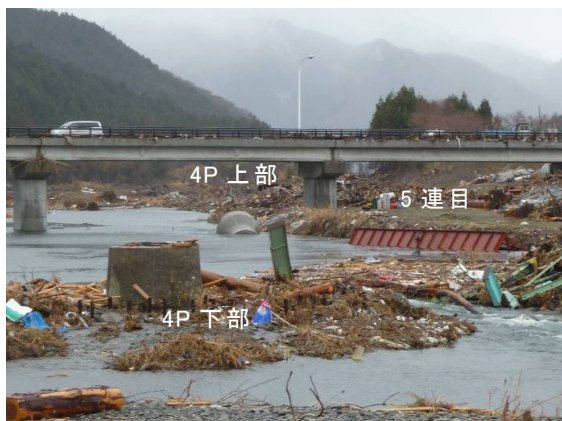
写真 2. 2. 34 気仙川橋りょう被害状況
