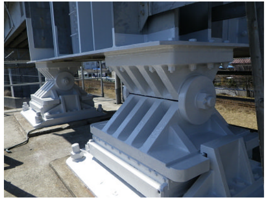
写真 2.2.13 PC 桁用受桁可動支承の復旧
