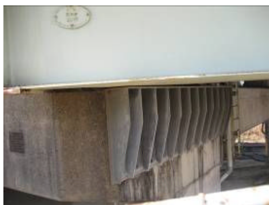
写真 2.2.25 落橋防止工への桁かかり
