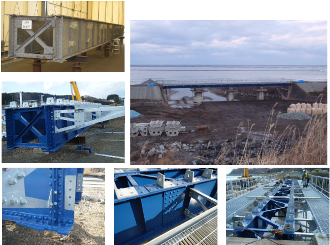
写真 2.2.35 大浜川橋りょう復旧状況
