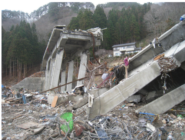
写真 2.2.29 三陸鉄道島越駅付近被害状況
