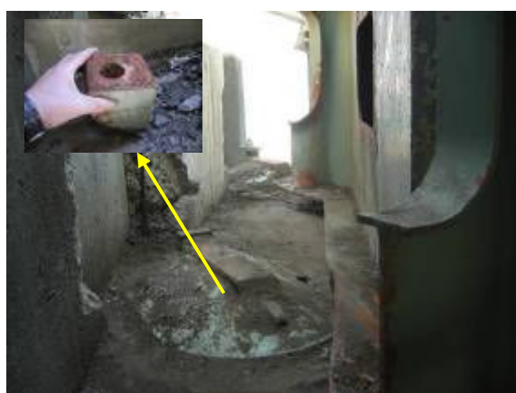
写真 2.2.26 支承損傷
