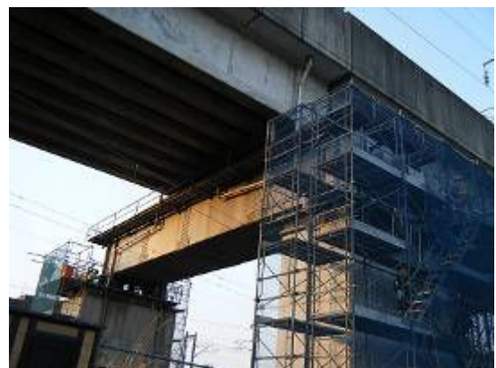
写真 2.2.9 東北貨物線線路橋 (PC 桁用受桁)
