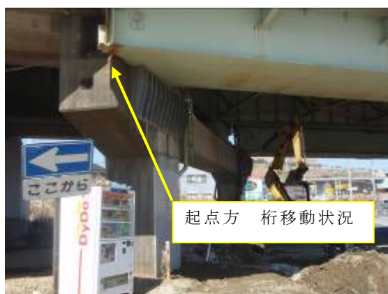
写真 2.2.24 桁移動
