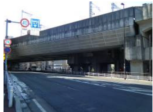
写真 2.2.14 花京院架道橋全景
