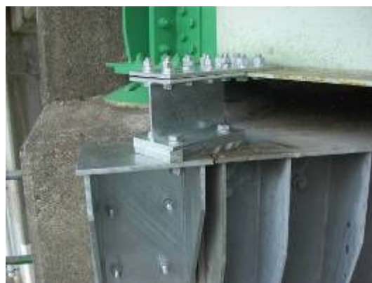
写真 2.2.28 桁移動制限装置の設置
