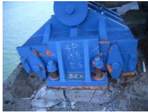
写真 2.2.21 沓座の破損
