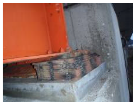
写真 2.2.6 調整プレート挿入
