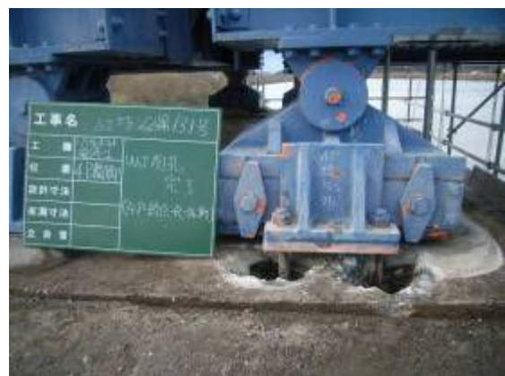
写真 2.2.22 アンカーボルトの取替え
