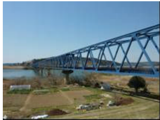
写真 2.2.19 北上川橋りょう全景
