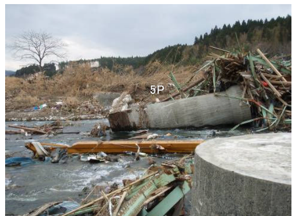
写真 2. 2. 34 気仙川橋りょう被害状況
