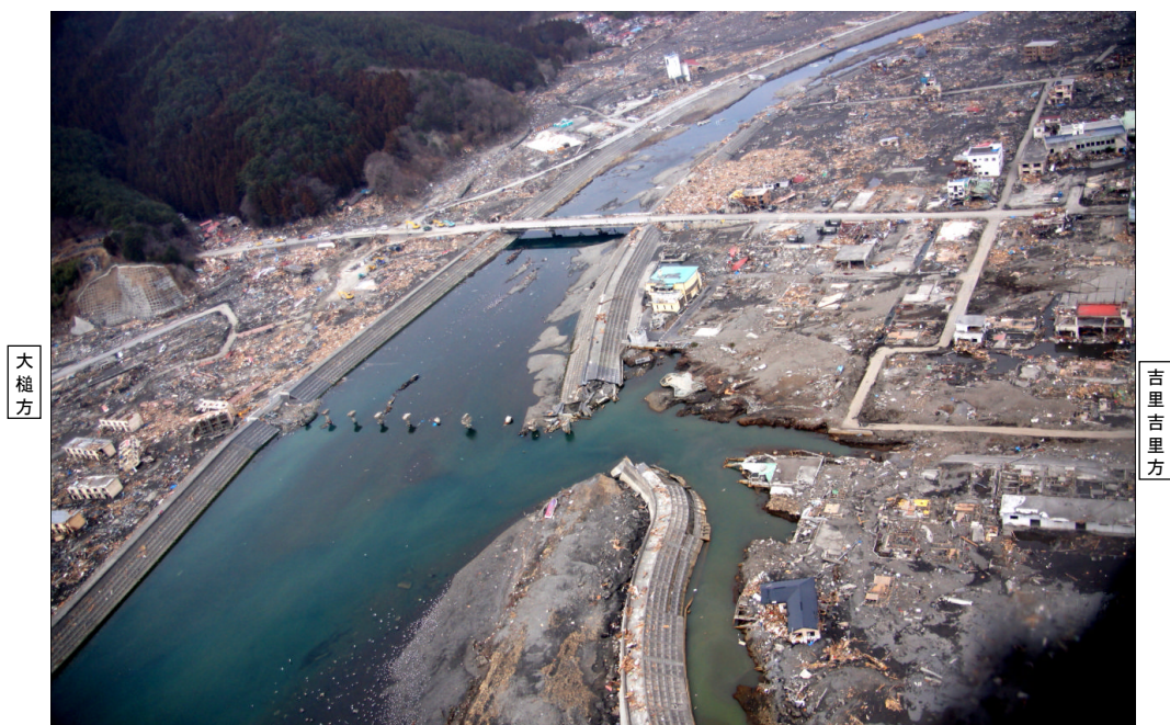
写真 2.2.32 大槌川橋りょう被害状況①
