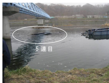
写真 2.2.31 第三十四閉伊川橋りょう被害状況
