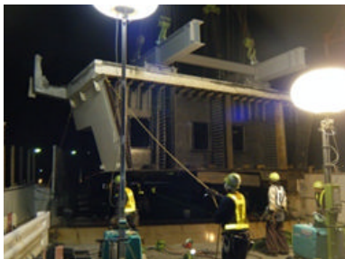
既設主桁ブロックの撤去
