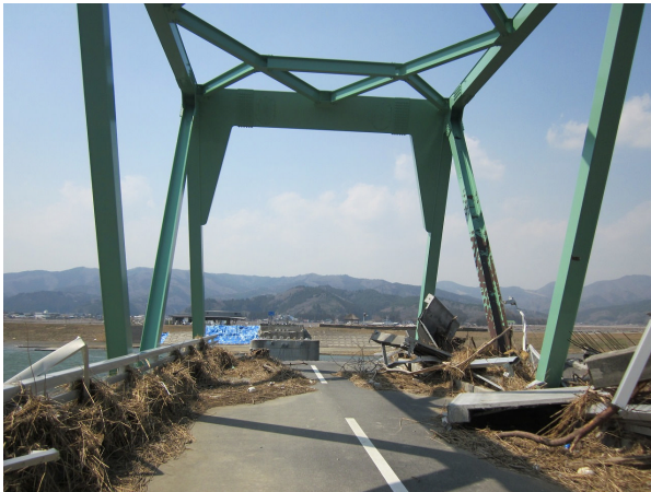
写真 2.1.69 流失した新北上大橋の状況 (2011 年 4 月 13 日撮影)
