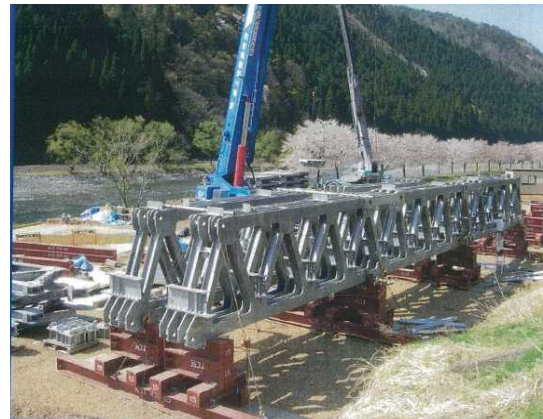
(a) トラスガーダー形式（陸前高田市川原川橋） (b) ワレントラス形式（近畿地整提供） 写真 2. 1. 95 応急組み立て橋
