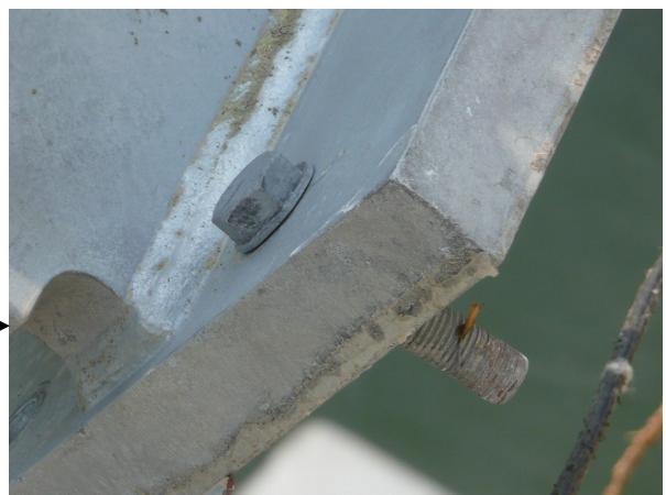
写真 2. 1. 84 落橋防止構造と残されたボルトの状態 (2011 年 4 月 14 日撮影)
