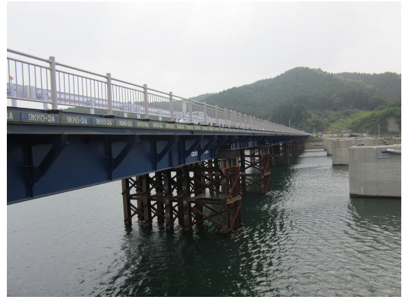
写真2.1.85 復旧状況 (2011年8月12日撮影)
