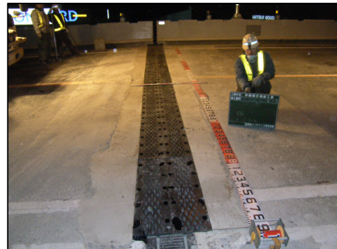
コンクリート打ち替え
