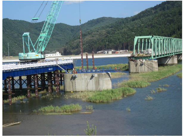
写真 2. 1. 72 鋼鈑桁の仮置きおよび仮橋の建設状況（2011 年 8 月 11 日撮影）
