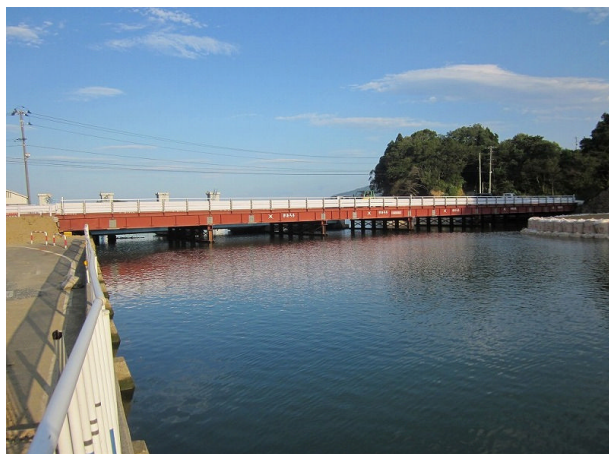
写真 2. 1. 79 復旧状況 (2011 年 8 月 11 日撮影)
