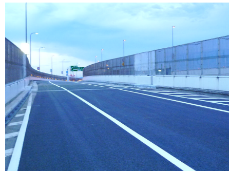
本復旧後の路面状況
