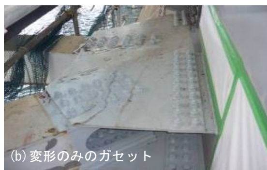
写真 2.1.66 ガセットの損傷状況
