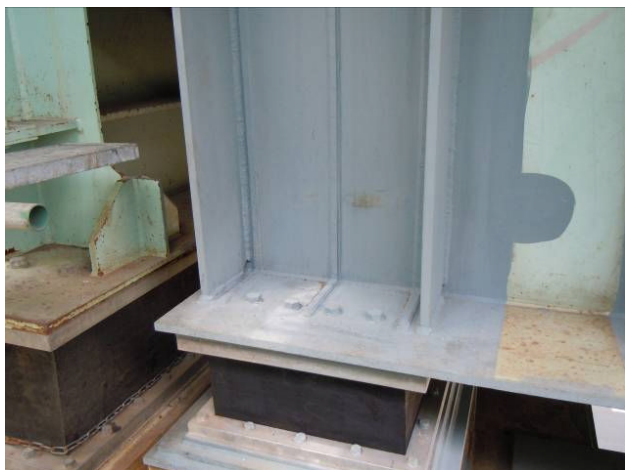
写真 2.1.49 支承取替え後の状況 (P56)
