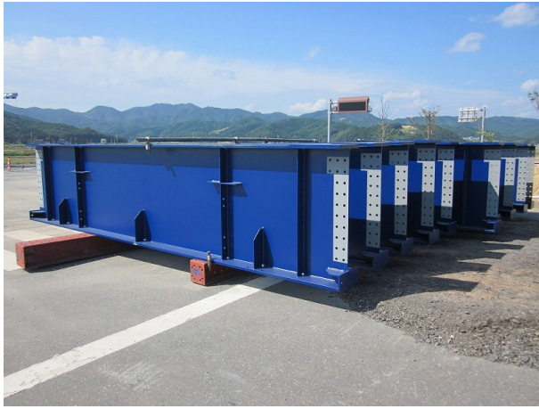
写真 2. 1. 72 鋼鈑桁の仮置きおよび仮橋の建設状況（2011 年 8 月 11 日撮影）
