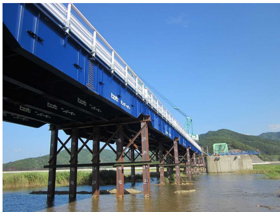
(a) 新北上大橋 (b) 水尻川橋 写真 2. 1. 96 仮設橋の例（鉸桁形式）
