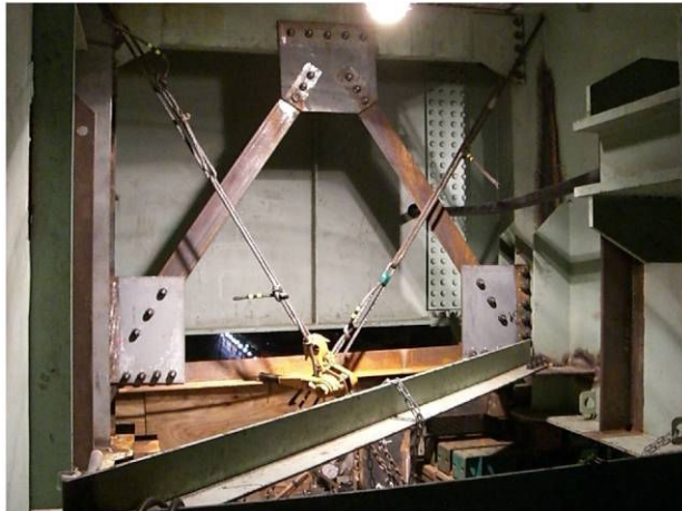
写真 2.1.54 対傾構補修部材の取付け状況
