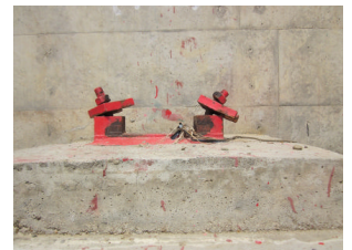
写真 2. 1. 74 横津橋の支承と落橋防止構造取付ボルトの状況（2011 年 4 月 15 日撮影）
