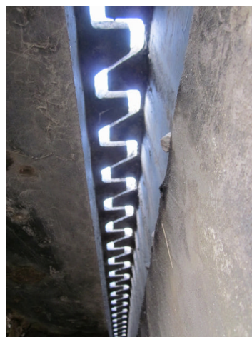
写真 2.1.14 土砂堆積の原因である排水型の伸縮装置
