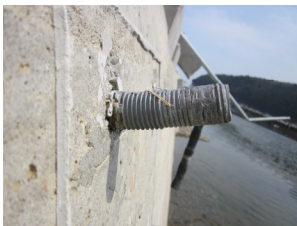
写真 2. 1. 74 横津橋の支承と落橋防止構造取付ボルトの状況（2011 年 4 月 15 日撮影）
