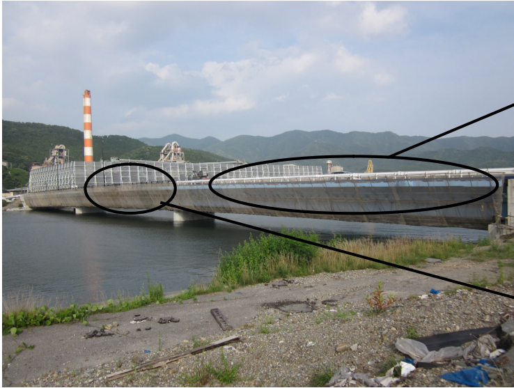
写真 2. 1. 93 漂流物により火災損傷を受けた橋 (2011年8月12日撮影)
