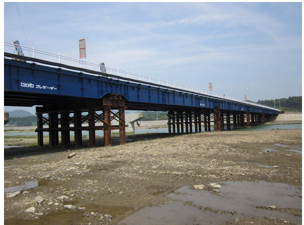
写真 2. 1. 82 復旧状況 (2011 年 8 月 11 日撮影)
