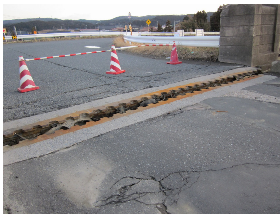
写真 2.1.16 支承の逸脱により段差が生じた伸縮装置の例
