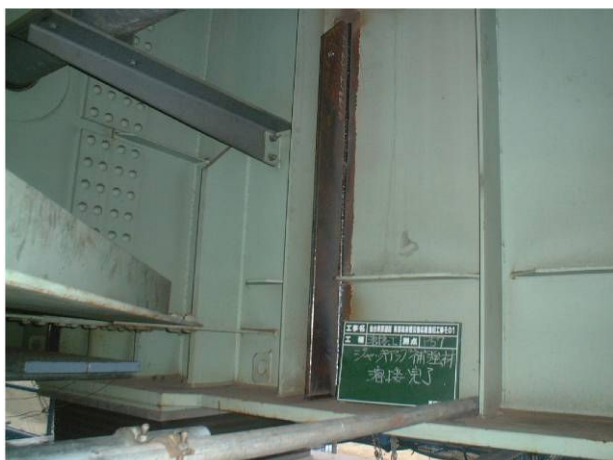
写真 2.1.52 ジャッキアップ用補剛材
