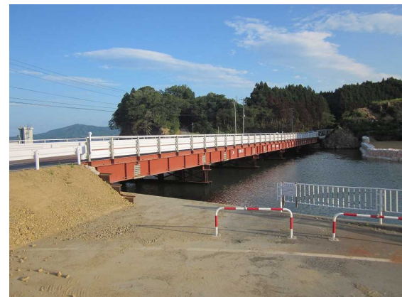
(a) 新北上大橋 (b) 水尻川橋 写真 2. 1. 96 仮設橋の例（鉸桁形式）
