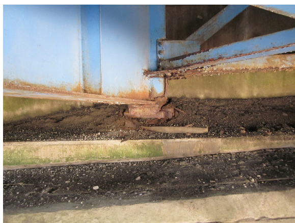
写真 2.1.15 土砂が堆積していた例
