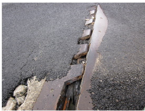
写真 2.1.20 フェースプレートの破損例（舗装後に徐行にて通行）
