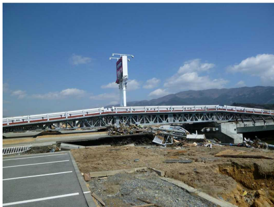
(a) トラスガーダー形式（陸前高田市川原川橋） (b) ワレントラス形式（近畿地整提供） 写真 2. 1. 95 応急組み立て橋
