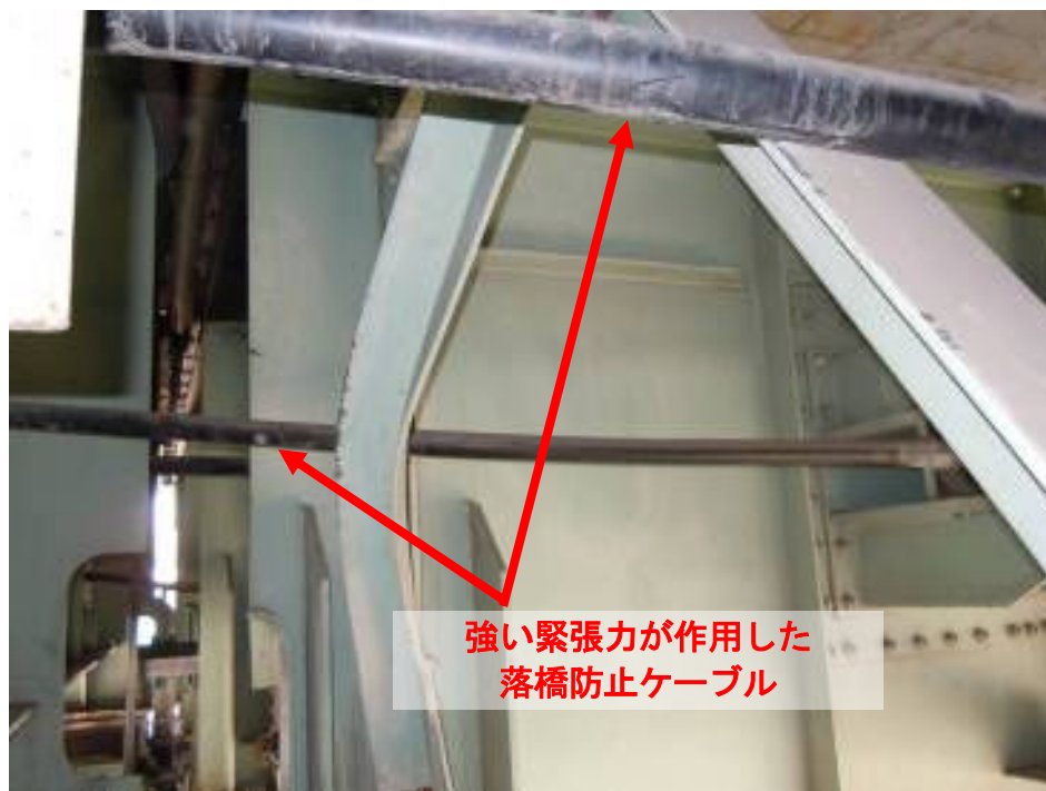
写真 2.1.40 P56 の落橋防止ケーブル
