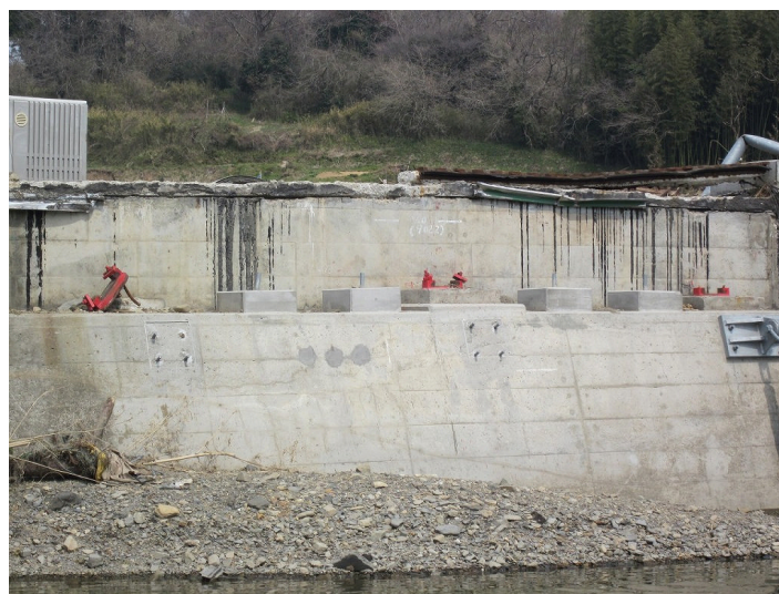
写真 2. 1. 74 横津橋の支承と落橋防止構造取付ボルトの状況（2011 年 4 月 15 日撮影）
