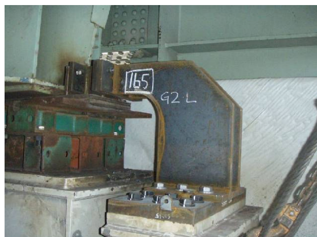
写真 2.1.48 仮設ジョイントプロテクター (P56)
