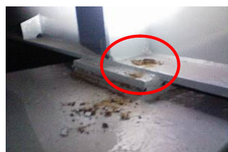
写真 2.1.68 床組み縦桁支承セットボルトの損傷状況と復旧状況
