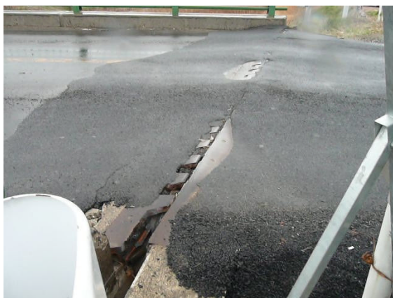
写真 2.1.20 フェースプレートの破損例（舗装後に徐行にて通行）
