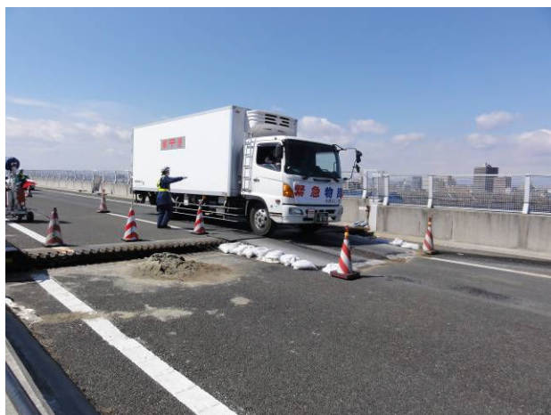
写真 2.1.57 段差すりつけ状況と 緊急車両走行状況
