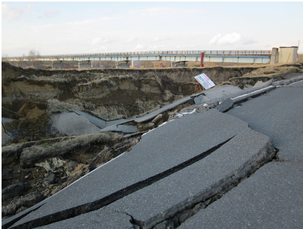
写真2.1.27 堤防の崩壊により通行止めとなった志田橋の全景
