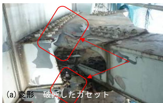
写真 2.1.66 ガセットの損傷状況
