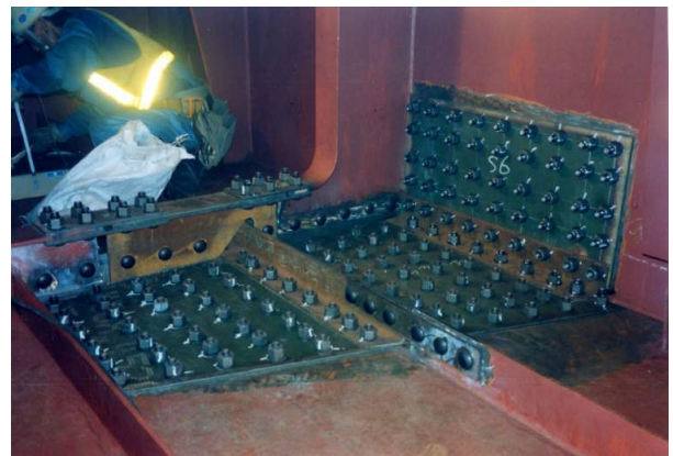
写真 2.1.92 当て板補修の例 2)
