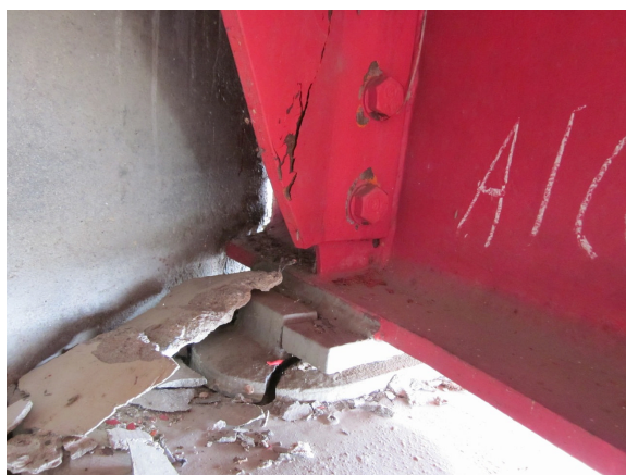
写真 2.1.21 床版の損傷例
