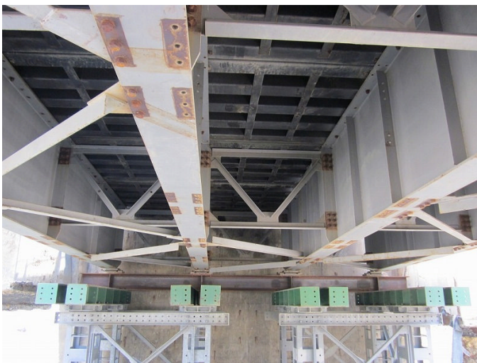
写真2.1.88 急速施工が行われた鋼鈑桁の仮橋の構造 (2011年8月11日撮影)
