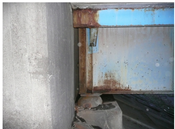
写真2.1.29 左岸側の桁端部・支点上補剛材は2段
