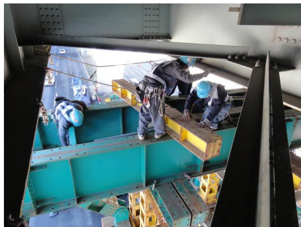
写真 2.1.50 仮設ベント設置状況（P56）
