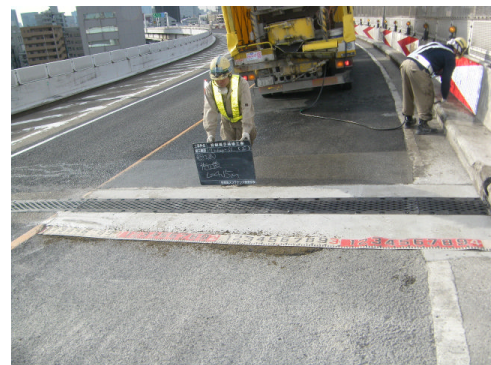
伸縮装置取り替え
