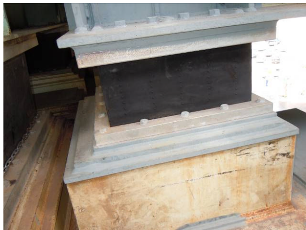
写真 2.1.49 支承取替え後の状況 (P56)
