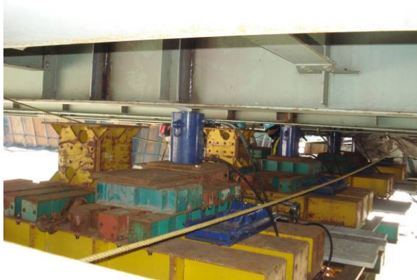
写真 2.1.53 仮設ベント上でのジャッキアップ状況
