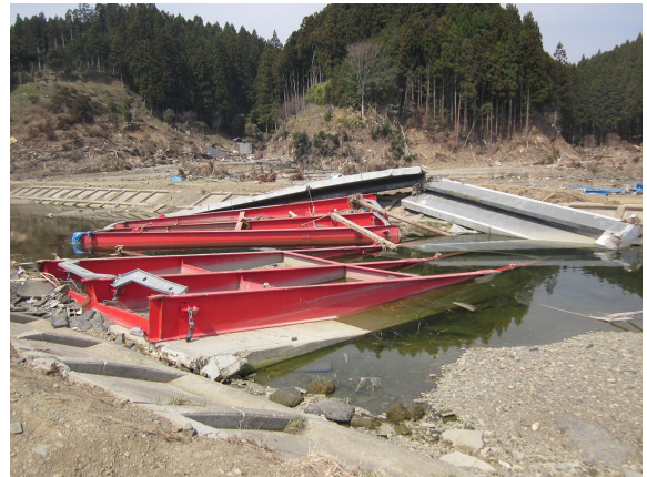
写真 2. 1. 73 流失した横津橋の状況（2011 年 4 月 15 日撮影）
