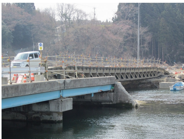
写真 2. 1. 78 復旧状況 (2011 年 4 月 15 日撮影)
