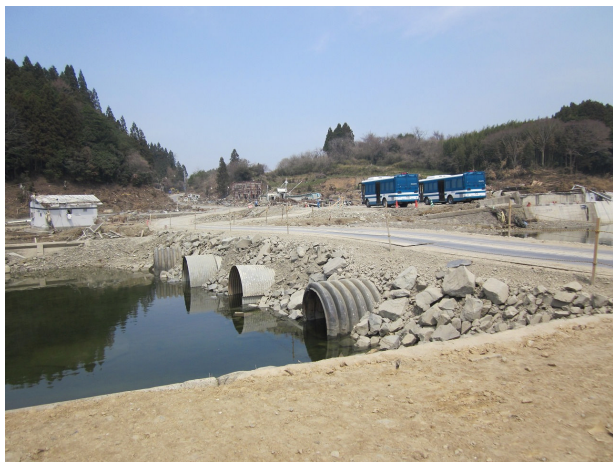
写真 2.1.75 復旧状況 (2011 年 4 月 15 日撮影)
