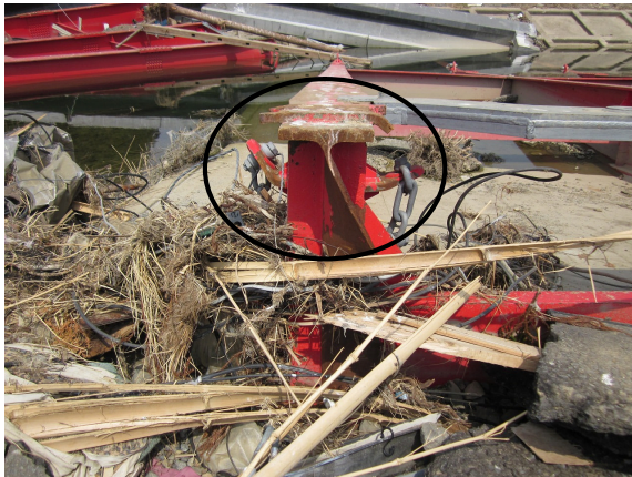
写真 2. 1. 73 流失した横津橋の状況（2011 年 4 月 15 日撮影）
