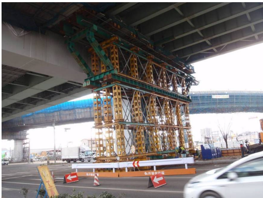
写真 2.1.51 設置が完了した仮設ベント（P56）
