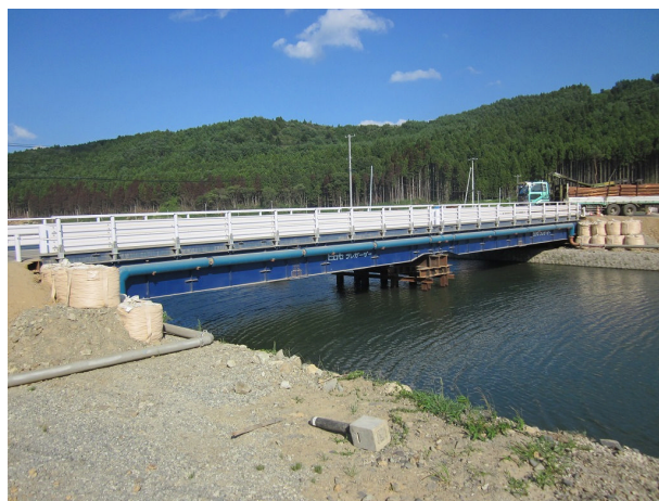
写真 2.1.76 復旧状況 (2011 年 8 月 11 日撮影)
