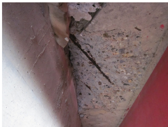
写真 2.1.21 床版の損傷例
