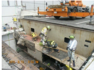
既設桁撤去後の状況
