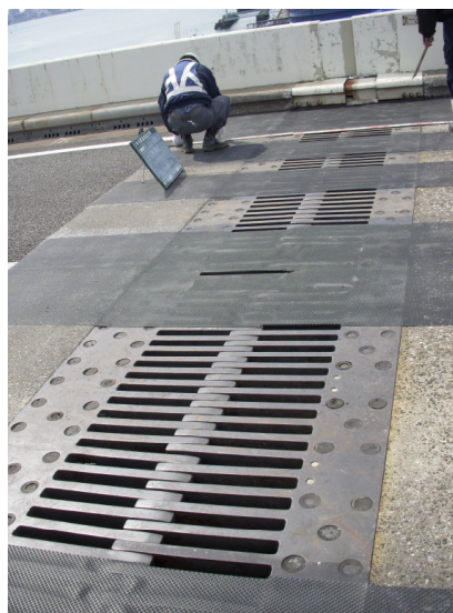
緊急補修材料による路面養生
