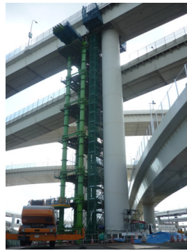
写真 2.1.64 仮設支柱（ベント）による応急復旧
