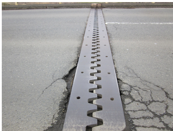
写真 2.1.17 段差が生じた伸縮装置の例
