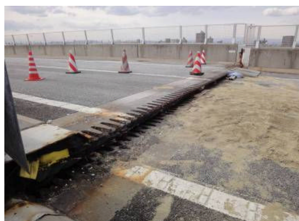
写真 2.1.44 P56 鋼製フィンガージョイント
