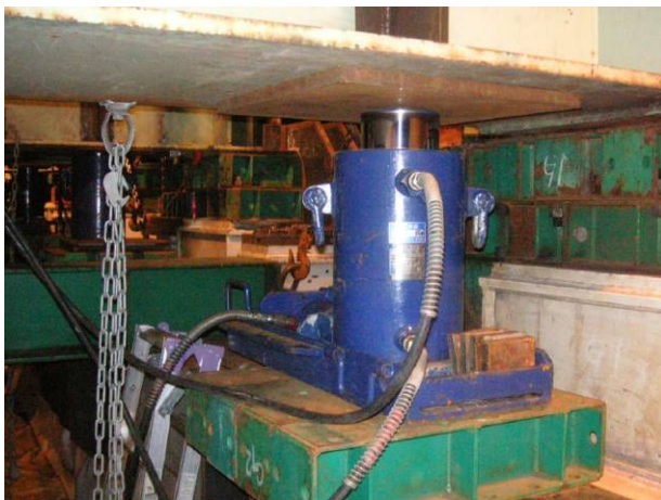
写真 2.1.56 ジャッキアップ及び桁横移動の状況
