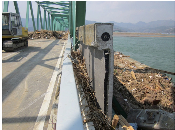
写真 2.1.69 流失した新北上大橋の状況 (2011 年 4 月 13 日撮影)
