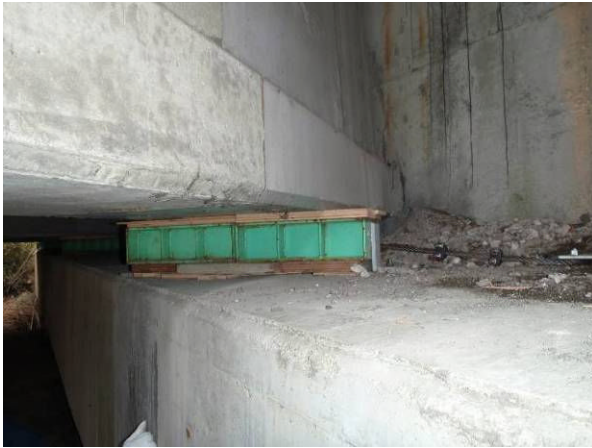
写真 2.1.34 サンドル支持およびラッシングによる応急措置
