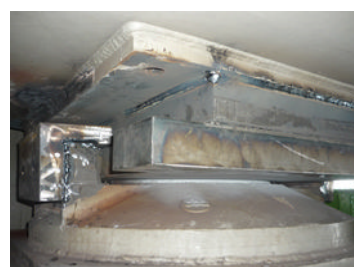
鋼材による仮復旧
