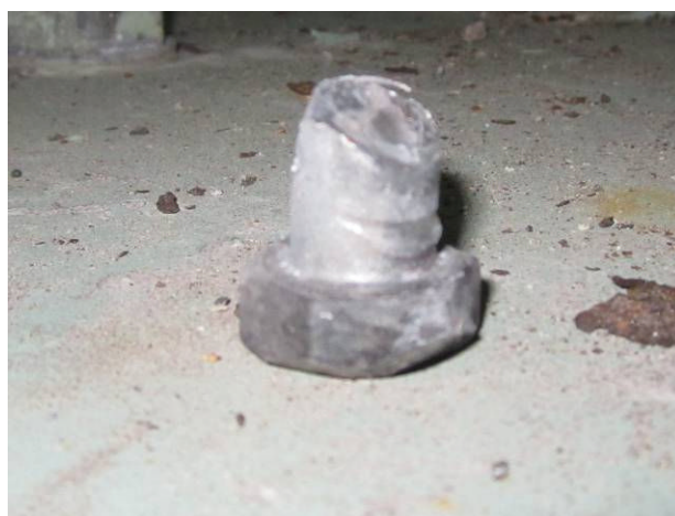
写真 2.1.42 ボルト破断面
