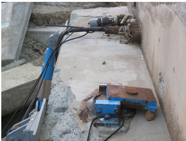
写真 2. 1. 81 残された落橋防止構造と支承 (2011 年 4 月 14 日撮影)
