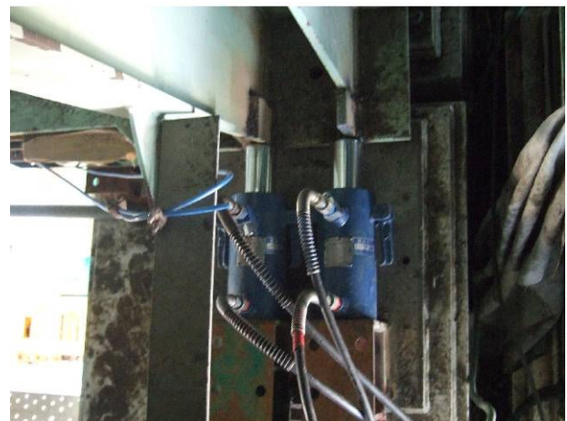
写真 2.1.56 ジャッキアップ及び桁横移動の状況
