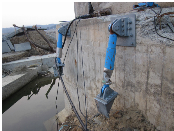
写真 2. 1. 81 残された落橋防止構造と支承 (2011 年 4 月 14 日撮影)
