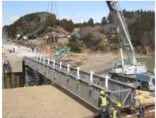
写真2.1.87 鋼製仮橋による建設状況 2) (2011年4月1日撮影)
