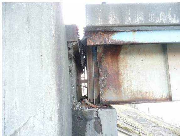
写真 2.1.16 支承の逸脱により段差が生じた伸縮装置の例
