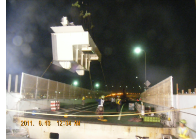
新設主桁ブロックの架設
