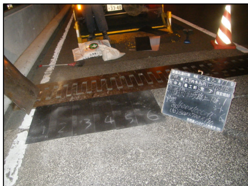
コンクリートの補修
