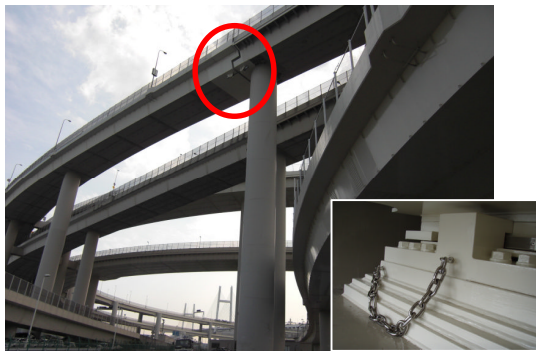
ゲルバー構造（上面），支承の取替完了
