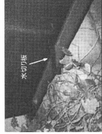
上下分離の隙間にシール
