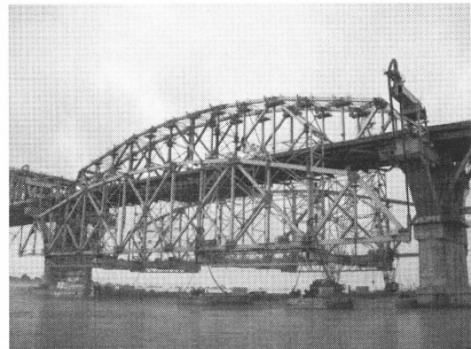
図-32 大ブロック吊上げ状況 (第3ブロック架設時)
