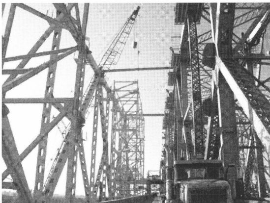
図-33 仮横構設置状況 (第1ブロック架設時)
