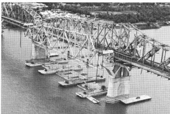
図-23 第1ブロック吊上げ
