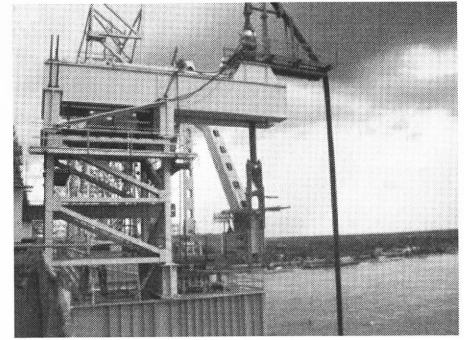
図-27 リフティングフレーム
