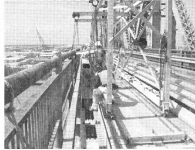
図-18 仮設壁高欄設置状況
