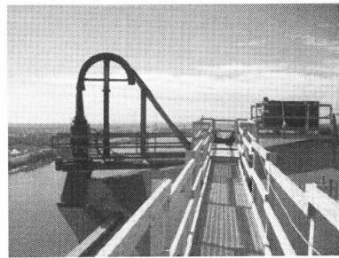
図-29 900t ストランドジャッキ (第2ブロック架設時)
