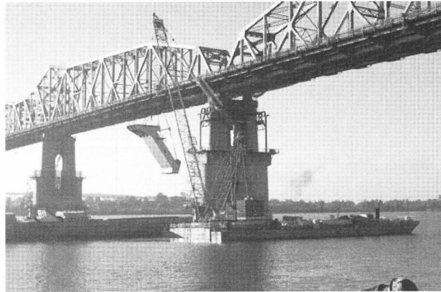
図-9 下部工拡幅状況
