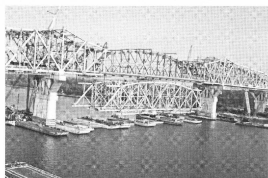
図-24 第2ブロック吊上げ
