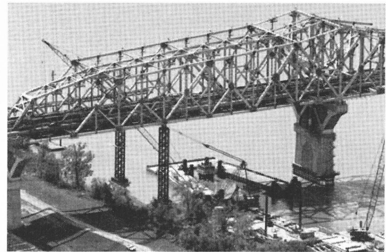
図-22 単材架設状況-支間端部 (中間脚側ベント撤去済み)
