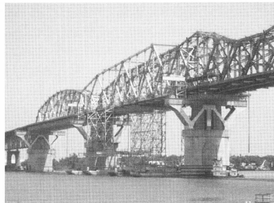
図-34 スタビリティフレーム降下状況 (第1ブロック架設時)
